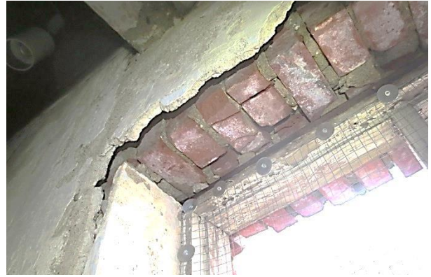
Kuva 7.15 Porrashuoneen ylimmän kerroksen ikkunan holvimuuraus on irronnut alustastaan
