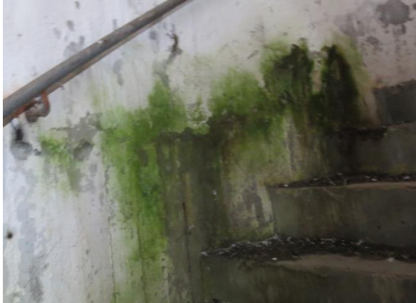
Kuva 6.8 Portaiden ulkoseinän kosteusrasitusta
