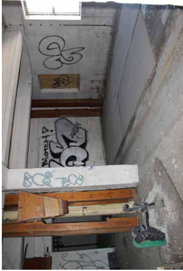
KUVA: Valssimyllyrakennuksen 2. kerros.
