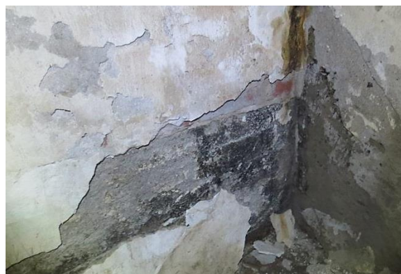
Kuva 7.5 Rappaus on irronnut kellarin nurkassa
