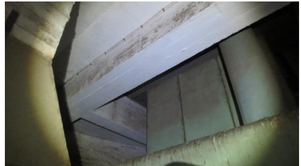
Kuva 6.19 Esipuhdistustornin toisen kerroksen katon palkkeja ja laatta
