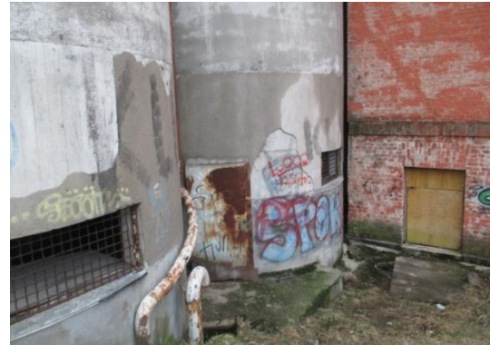
Kuva 6.29 Viljasiilojen alaosan rappauspinnan vauriot
