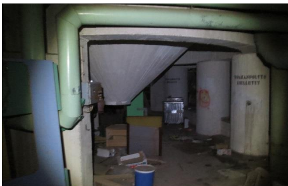
Kuva 6.14 Siiloja kannatteleva seinäpalkki ja pilarit
