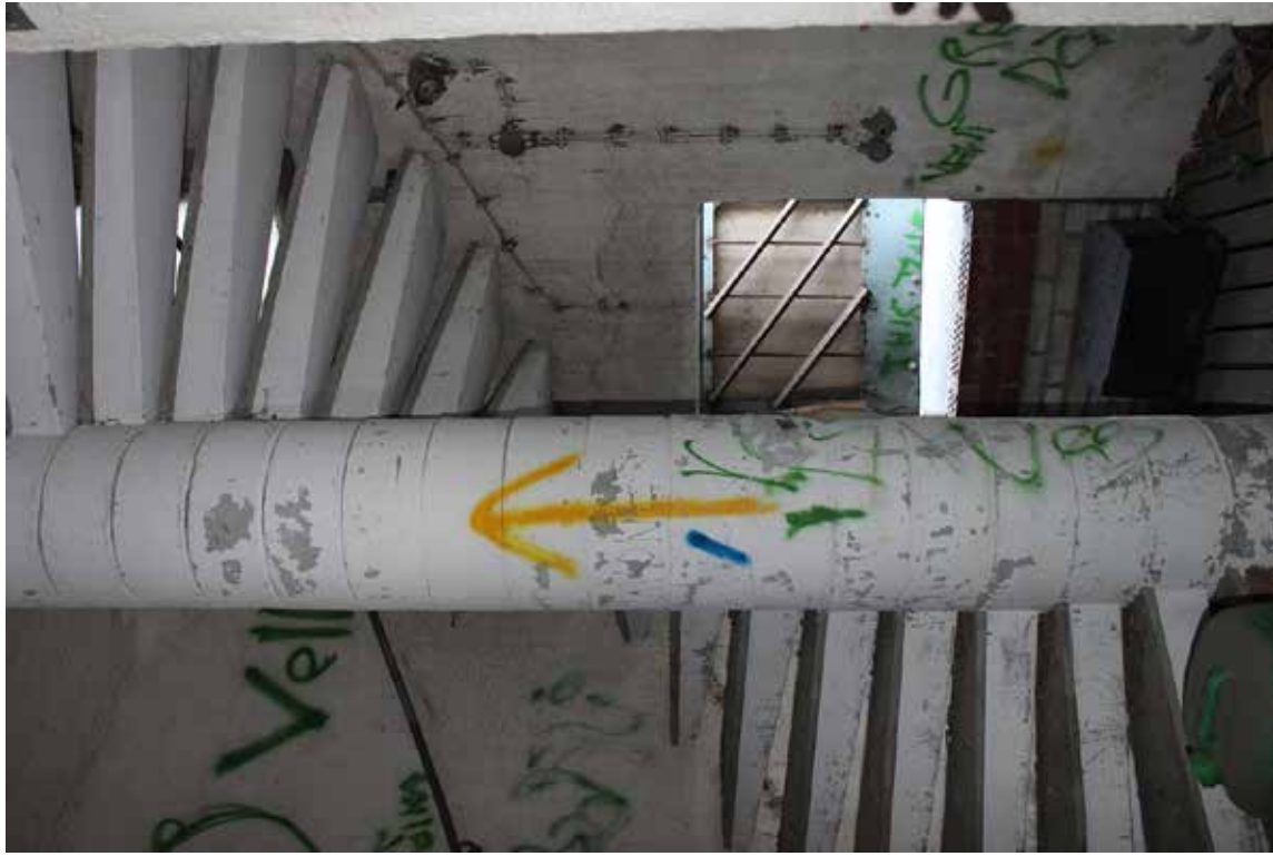
KUVA: Vijasiilorakennuksen porrashuone. Porrashuoneen sisäänkäynti johtaa Mannerheimintien ja Raatihuoneenkadun kulmaukseen.
