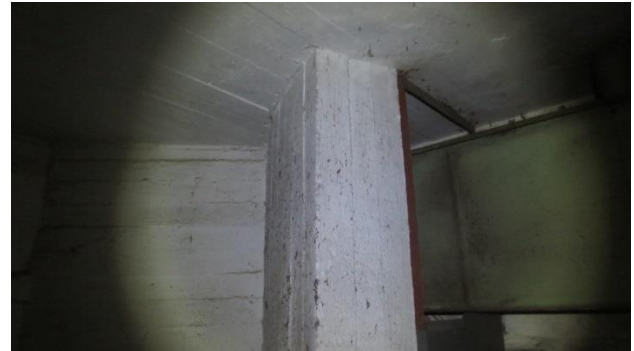
Kuva 6.13 Siilon alapuolinen kaareva seinä ja kellarin katto
