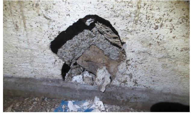
Kuva 6.11 Ulkoseinässä toja-levyä
