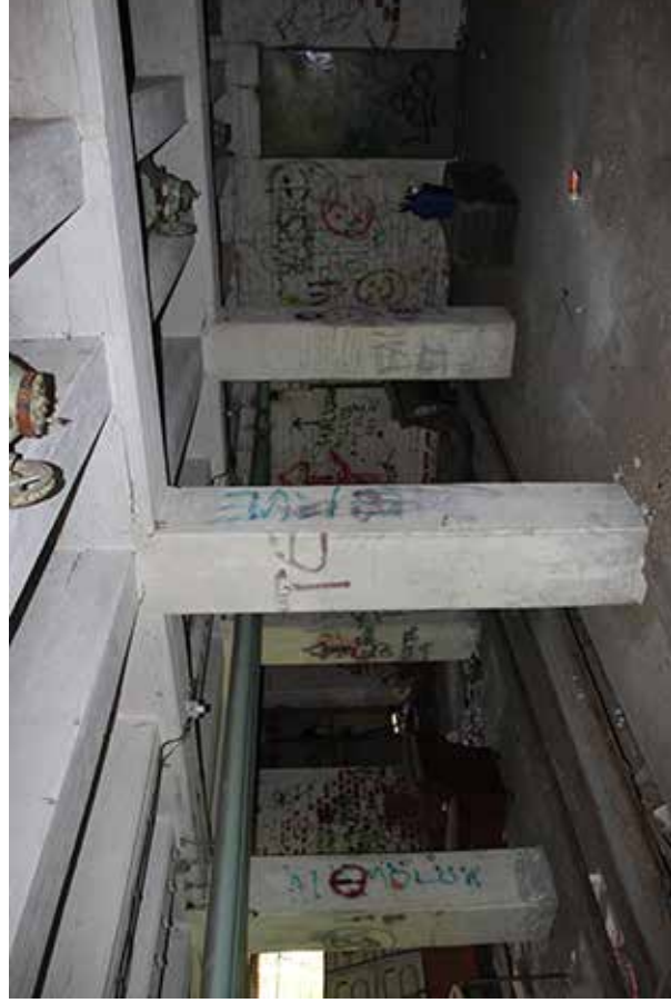
KUVA: Vanhan viljavaraston 1.kerros. Katossa näkyvät puurakenteisten viljasilojen suuttimet. Kuvassa oikealla oleva teräsovi johtaa viljasiloon (1963).
