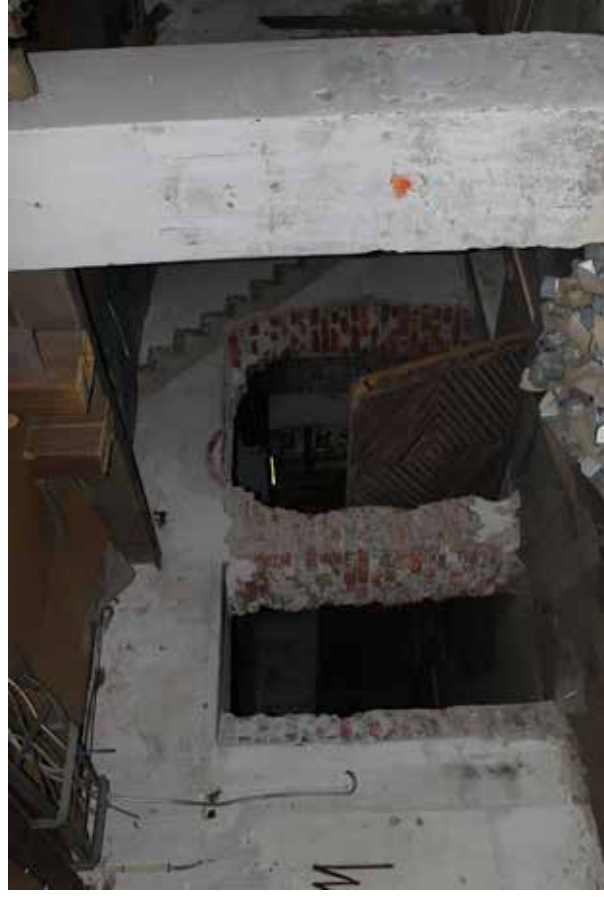
KUVA: Entisen puhdistuslaitoksen (1921) 1.kerrosken ja myllyosaston (1941) väliseinään on puhkottu aukkoja. Yläkerroksiin menevät portaat ovat purettu, mutta kellariin johtavat portaat ovat säilyneet.
