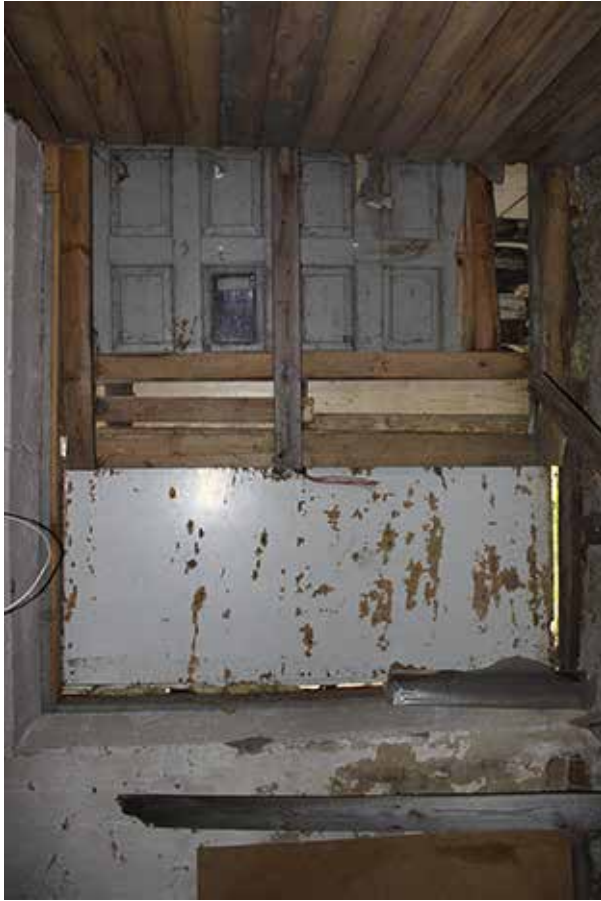
KUVA: Pihan puoleinen sisäänkäynti puhdistuslaitokseen (1921). Kuvassa oikealla luultavasti 1960-luvulla rakennettu sisäkäymälän lautaseinä.
