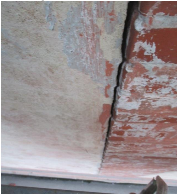
Kuva 7.22 Halkeama/liikuntasauma julkisivussa rappauksen ja tiiliseinän välissä
