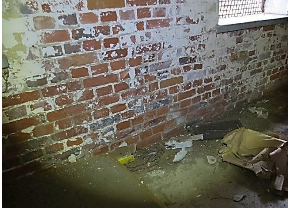
Kuva 7.14 Tiiliseinän pintavaurioita
