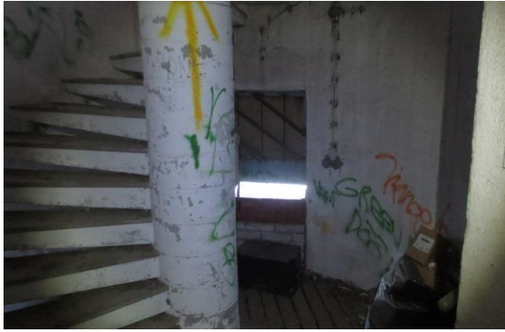
Kuva 6.10 Kellariin johtava porrashuone
