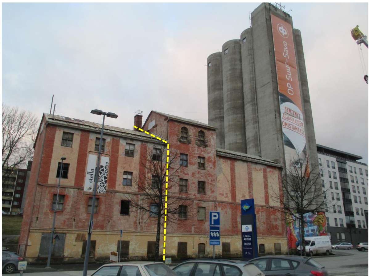
Kuva 3.1 Valssimyllyn ja viljasiilon julkisivukuva. Keltaisen katkoviivan vasemmalla puolella on valssimyllyn laajennusosa.
