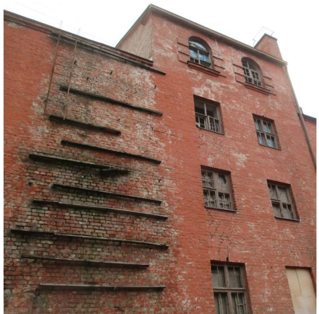
Kuva 7.23 Vaurioitunut sisäpihan julkisivu
