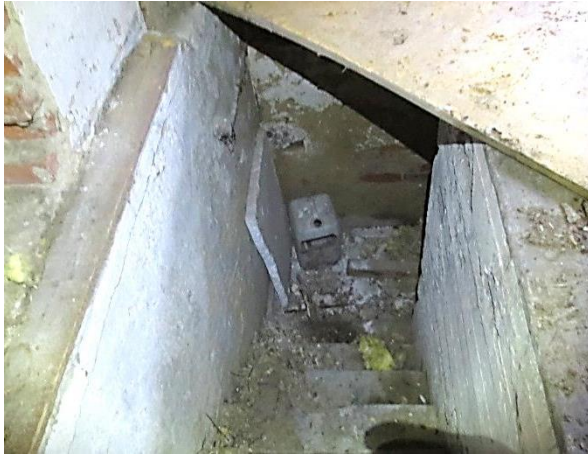
Kuva 7.8 Puhdistuslaitoksen kellariin johtavat portaat
