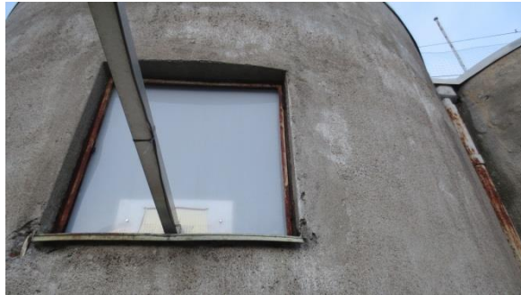
Kuva 6.28 Korroosio ja rapautuma vaurioita ikkunan alakulmissa
