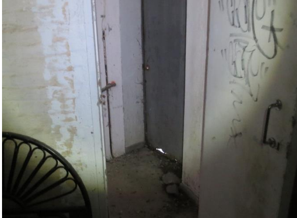
Kuva 6.6 Kulku kellarin portaisiin sillojen välistä
