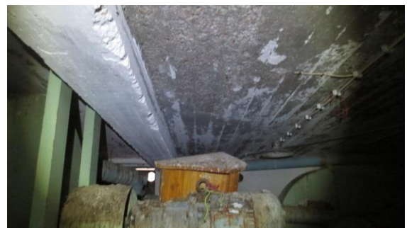
Kuva 6.23 Kantavuuden kannalta merkittävää rapautumaa ullakon korotusosan betonilaatassa ja palkissa
