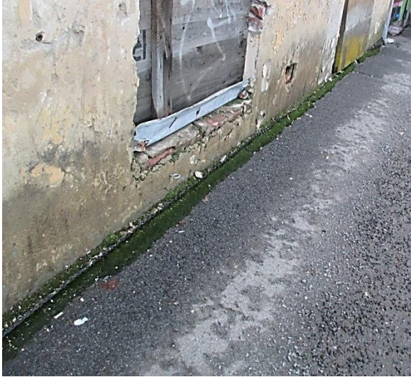
Kuva 7.20 Seinän vierellä oleva patolevy kadonnut sammaleen joukkoon
