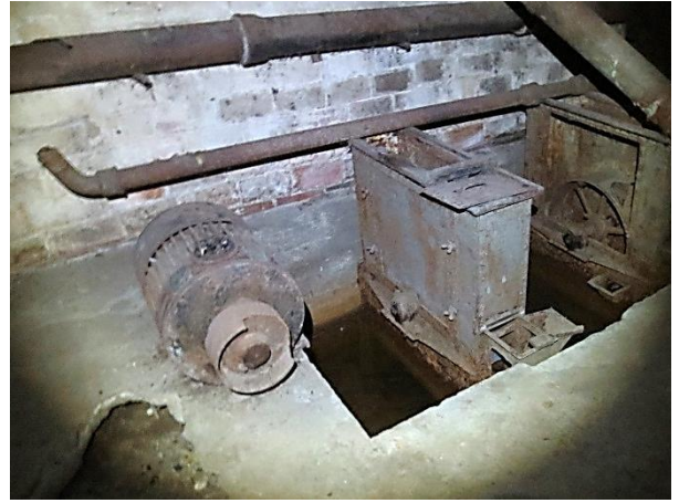
Kuva 7.9 Kellarissa sijaitsee myllyn pumppaamo
