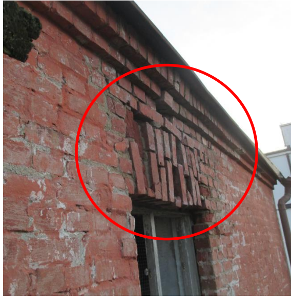
Kuva 7.24 Ikkunan vaurioita porrashuone
