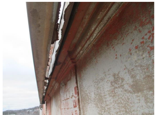
Kuva 7.27 Läpiruostunut räystäskouru
