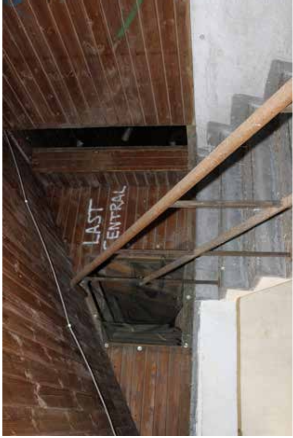
KUVA: Valssimyllyrakennuksen porrashuone ja viinttikerroksen tasanne.
