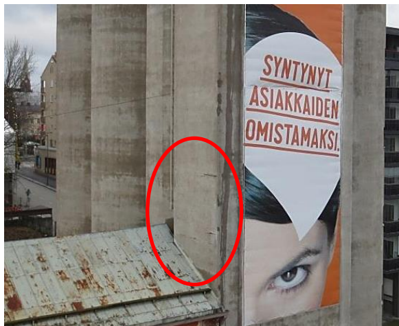
Kuva 6.24 Raudotteiden korroosion aiheuttamia vaurioita
