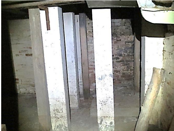
Kuva 7.10 Kellarin pilareita, joiden alaosassa rapautumaa
