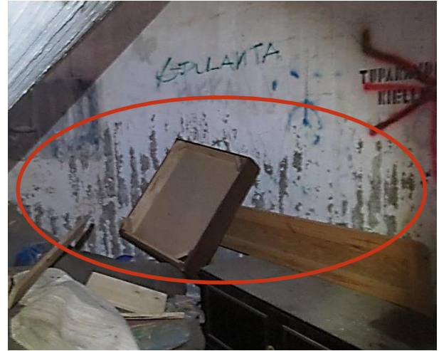
Kuva 6.17 Rinteen puoleisen seinän maalipinta hilseilee
