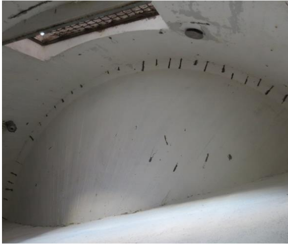
Kuva 6.16 Seinän ja siilon suppilon liitoskohdan korrosiovaurioita
