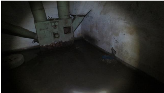
Kuva 6.12 Kellarissa vettä lattialla
