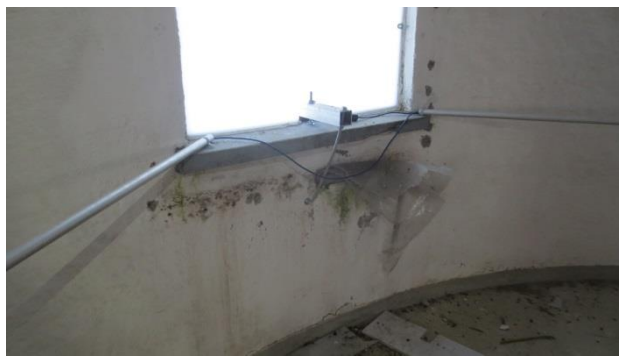
Kuva 6.22 Vähäistä betonipinnan rapautumaa ullakon ikkunoiden alla
