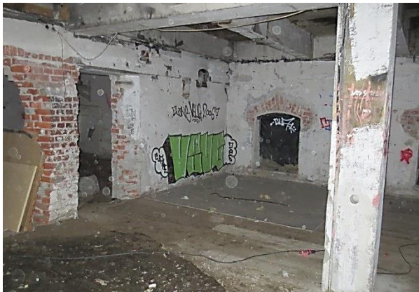
Kuva 7.12 Yleiskuva myllyosastosta ja puhdistuslaitokseen vieviltä oville
