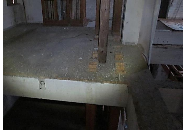
Kuva 7.18 Lautalattiaa paikoitellen paikoillaan
