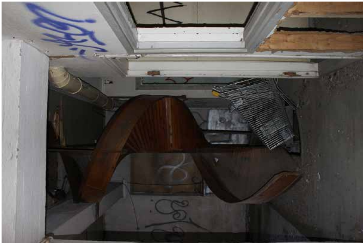
KUVA: Myllyosaston puinen liukuränni on kulkenut usean kerroksen kautta. Vuonna 2016 osa rännistä puuttuu.
