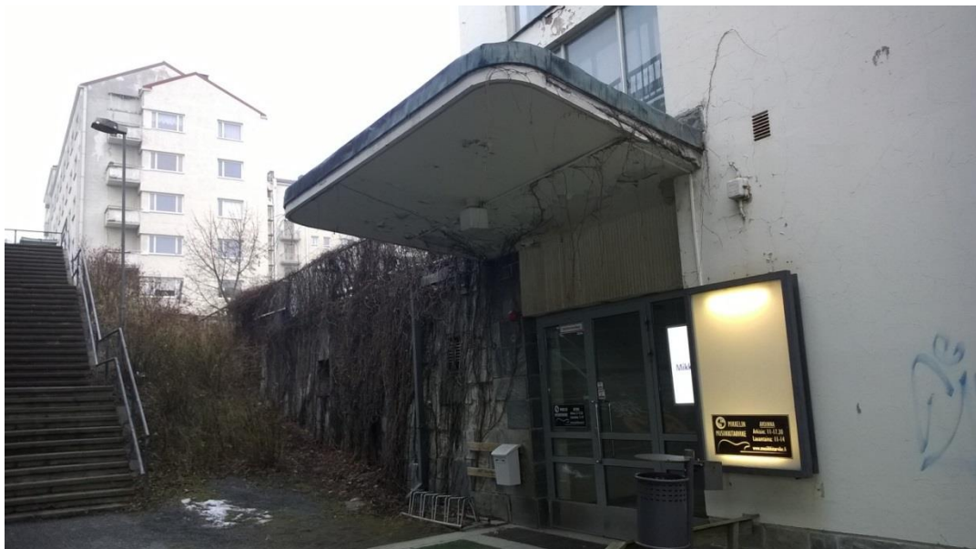
kuva 10, eteläpäädyn sisääntulokatoksen maanalaisen osan seinän viereiset istutukset tulisi poistaa
