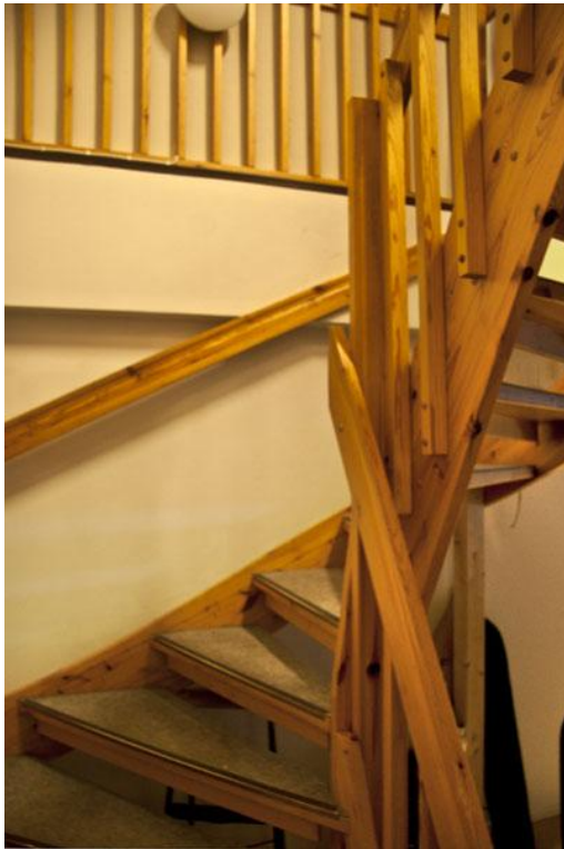
Toimistokerrosten väliin on rakennettu puiset porraskaiteet mitä todennäköisimmin 1980-luvulla. Kuva Pekka Piiparinen
