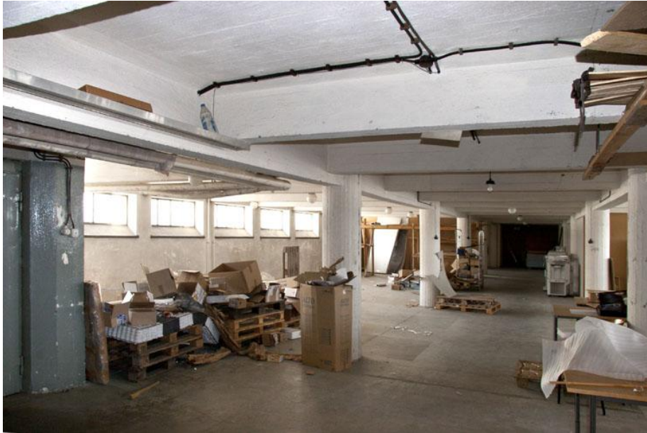
Varasto-osastoissa näkyy vahvasti talon rakenteellisia elementtejä. Kohteen runkojärjestelmänä on paikallaan valettu pilari-palkkijärjestelmä. Kuva Pekka Piiparinen
