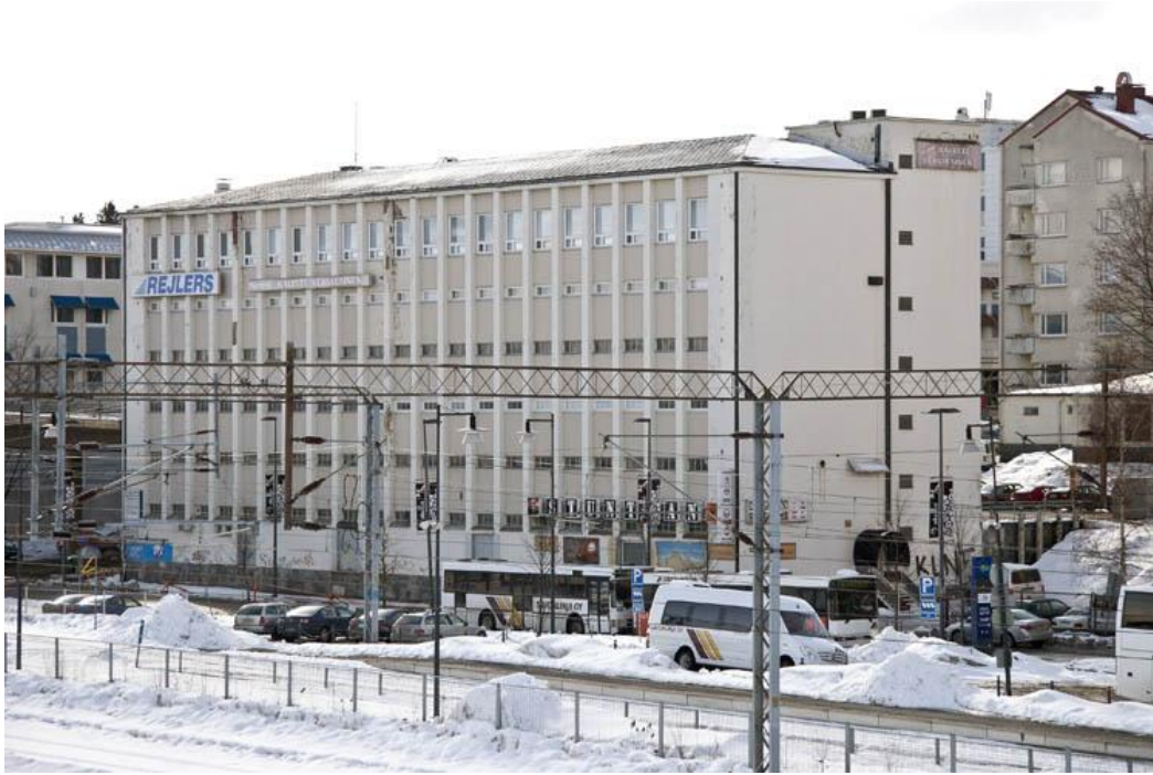
Itäistä ja pohjoista julkisivua. Edessä kulkee Mannerheimintie. Kuva Pekka Piiparinen
