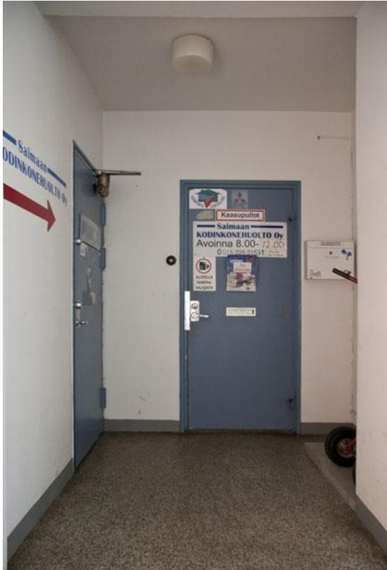
Pääporraskäytävän rautaovia, jotka lienevät alkuperäisiä. Kuva Pekka Piiparinen
