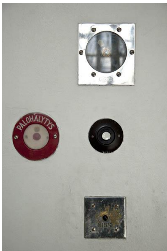
Hissin ulkopuolella olevaa seinustaa, jossa on mm. alkuperäinen kerroslukumittari ja hissien kutsupainike. Kuva Pekka Piiparinen
