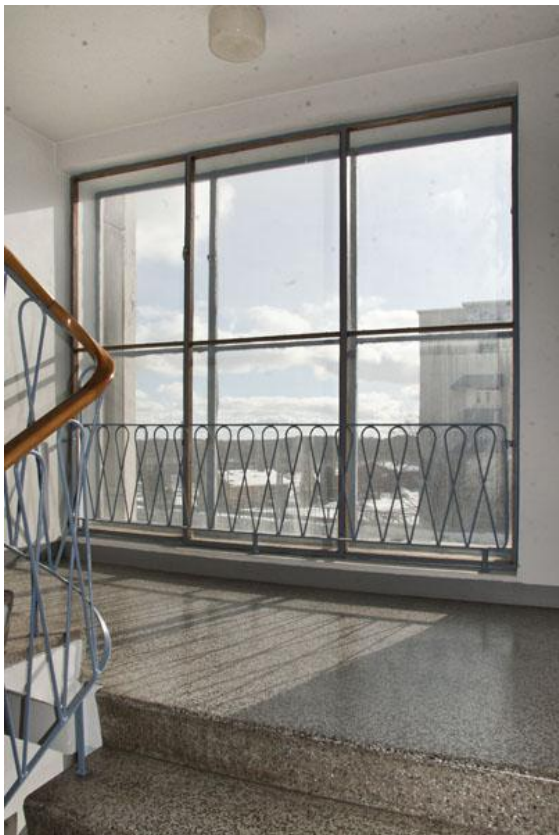
Pääporraskäytävässä ovat säilyneet mm. alkuperäiset rautaiset porraskaiteet ja ikkunansuojukset. Näiden lisäksi alkuperäistä ilmettä tuovat myös marmorimosaiikista valetut portaat ja lattiat. Kuva Pekka Piiparinen
