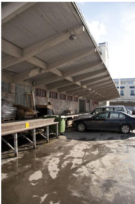
Lastauslaiturin palkit on tehty teräsbetonista, kun taas palkkien päällys on 2 ½ tuuman ponttilankusta. Katto on päällystetty kuparipellillä. Kuva Pekka Piiparinen
