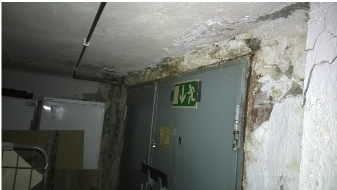
kuva 21, kellarin vesivaurioita
