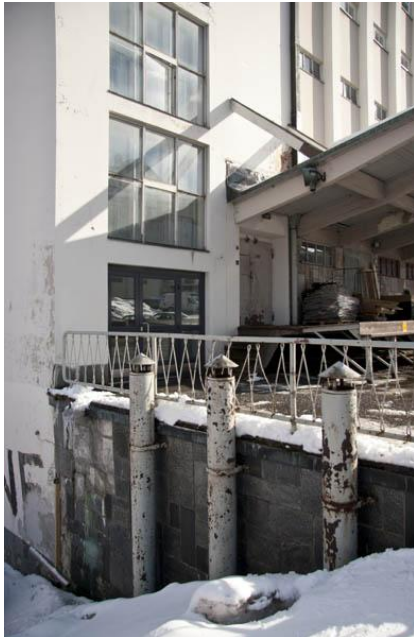
Yksityiskohta kohteen pohjoisen ja läntisen julkisivun yhtymäkohdasta. Sokkeli on vuorattu luonnonkivillä. Kuva Pekka Piiparinen
