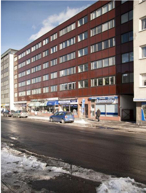
Asunto Oy Porraskartano (1975) on vedetty hieman sisään viereisten rakennusten katulinjasta. Rakennuksen on suunnitellut Unto Kärkkäinen. 8 Kuva Pekka Piiparinen
