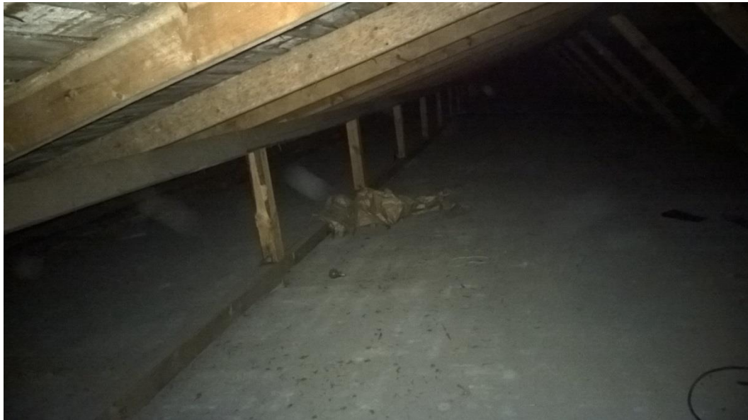
kuva 15, vesikaton puurakenne on tuettu ullakon palopermantoon
