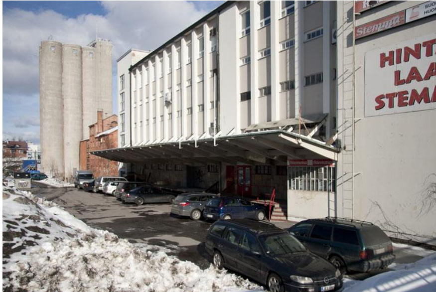
Lastauslaituri sijaitsee rakennuksen länsipuolella. Taustalla siilo ja valssimyllyn rakennus. Kuva Pekka Piiparinen
