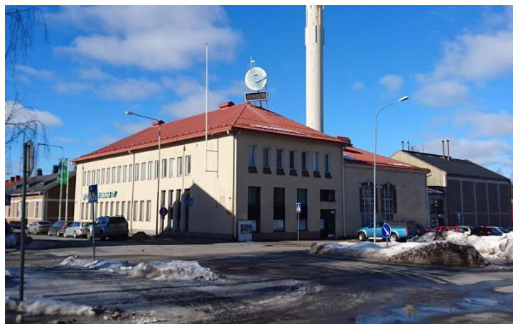
Kuva: Mikkelin sähkölaitos, nykyinen ESE:n hallintorakennus.
