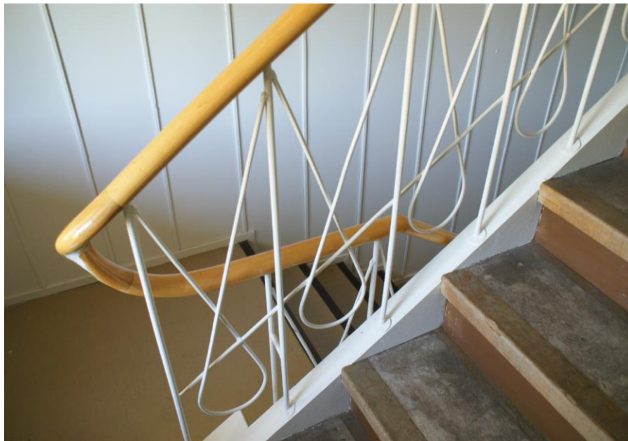
Kuva: Pääporrashuone. Lepotasollinen suoravartinen portaikko, jonka kaiteessa on puinen lakattu käsijohde ja pystypinnat kapeasta teräsputkesta silmukakoristeluin.
