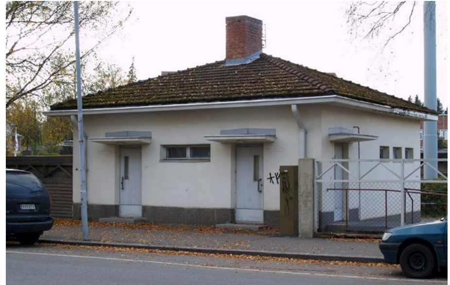
Julkisivut Mikonkadulle ja luoteeseen.
