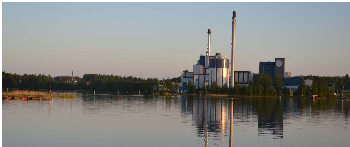
Rantarakentaminen näkyvällä paikalla voi olla kokonaismaiseman kannalta häiritsevä. Näkymä on kuvattu Kenkäveronniemen valtakunnallisesti arvokkaalle rakennetulta ympäristöltä. Pursialan teollisuusalue ja voimalaitos erottuvat voimakkaasti Pappilanselän maisemassa Tuppuralan rantareitiltä kuvattuna. Toisaalta voimalaitos valoineen on vaikuttava näky talvisessa pimeässä kaupunkimaisemassa. Taustalla näkyvät myös 100 kv voimalinjat ja korkea linkkimasto sekä teollisuusrakentamista. Räinen, K
