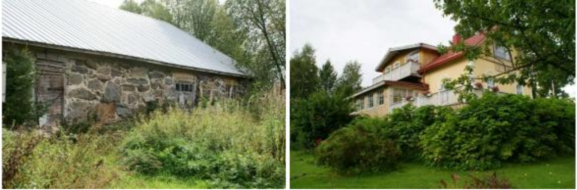
Kuva 19 Vasemmalla Rautialan kavinavetta ja oikealla Niemelän päärakennus, jonka kuistit ja parveke ovat uudemmaa kerrostumaa. (kuvat: Kulttuuriselvitystyö Ahola)
