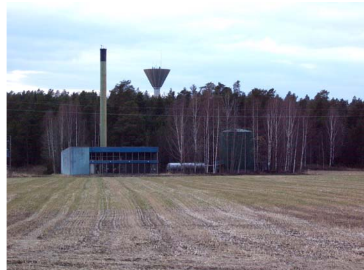
Lämpökeskus sijaitsee hyvin näkyvällä paikalla Moisionpellon laidassa.
