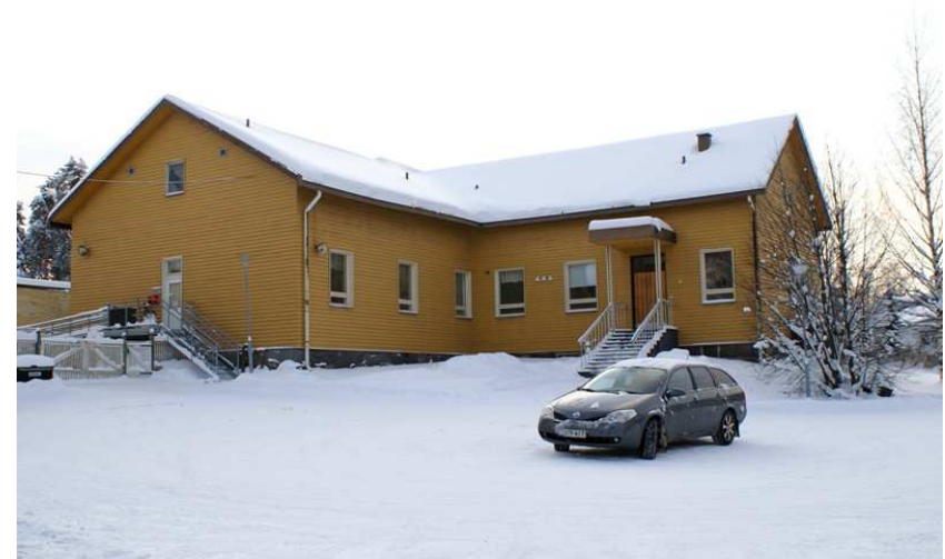
Kuva: A-rakennuksen koillispääty ja 1920-luvun siipiosa.
