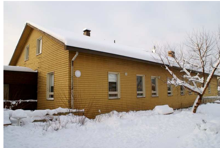
Kuvat: B-rakennus. Rakennuksen vanhasta 1890-luvun ulkoasusta on jäljellä harjakattoinen perushahmo. 1960-luvun parveke on purettu päädyistä.
