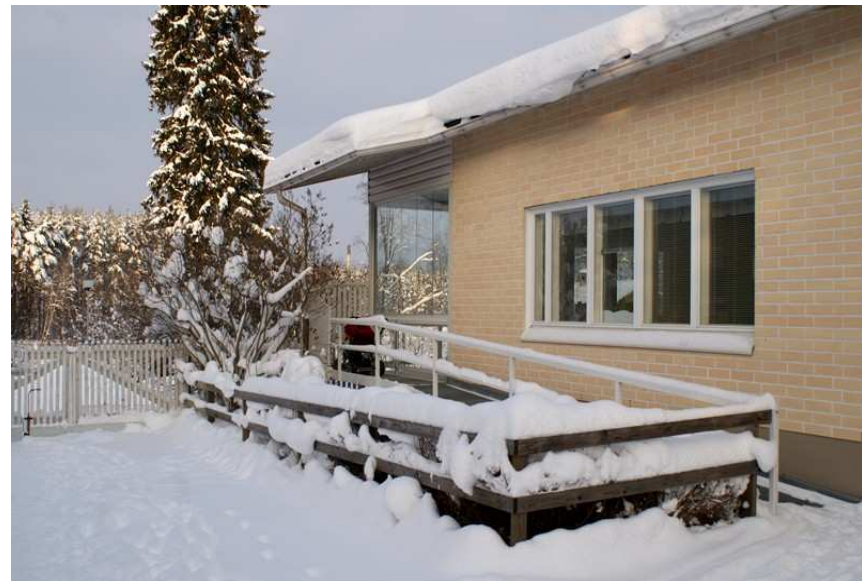
Kuva: C-rakennuksen lammenpuoleisessa päädyssä on lasitettu parveke.
