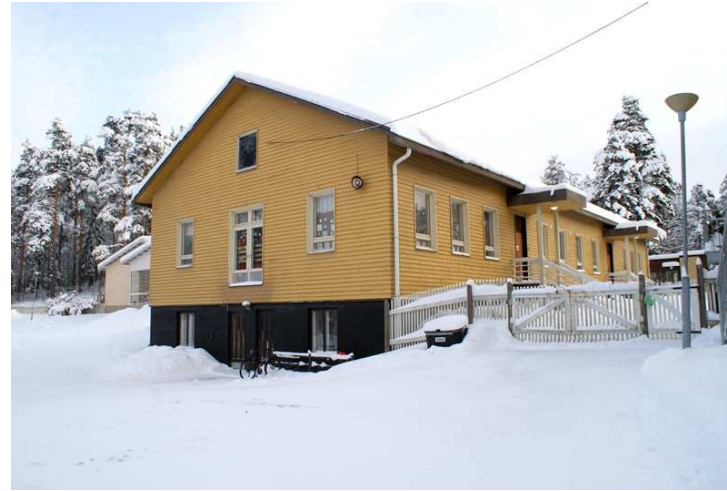
Kuvat: B-rakennus. Rakennuksen vanhasta 1890-luvun ulkoasusta on jäljellä harjakattoinen perushahmo. 1960-luvun parveke on purettu päädyistä.
