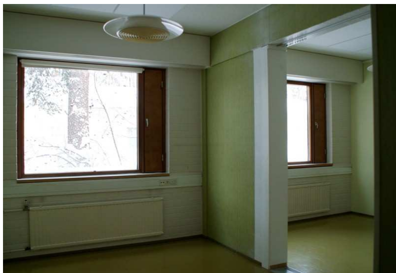
Kuva: Asuntosiiiven kapeita huoneita, jotka on myöhemmin yhdistetty isommaksi tilaksi väliseinään puhkaistulla aukolla. YHDYSKÄYTÄVÄ
