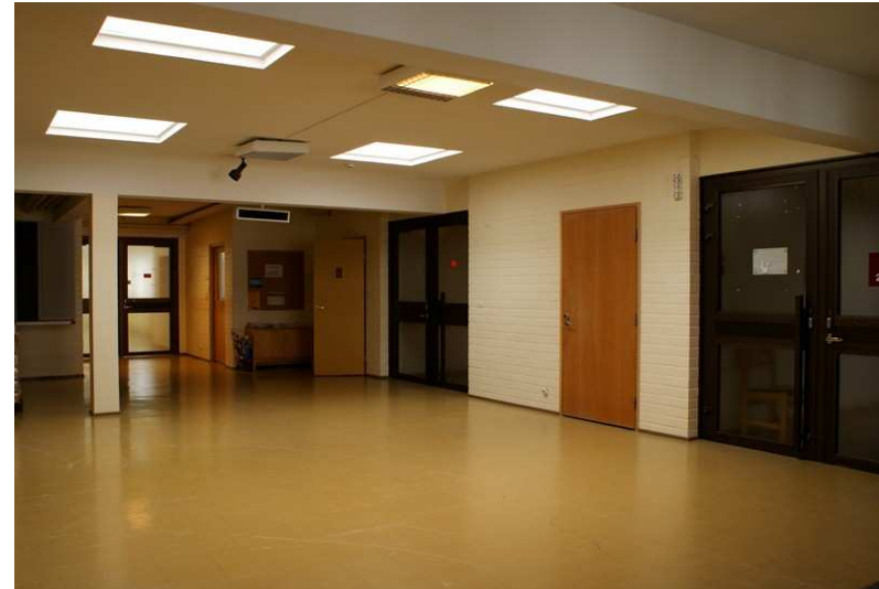
Kuva: Avarissa tiloissa, kuten aulassa, tulee näkyvillä rakennuksen pilaripalkkirunko. Katossa näkyvät valokuilut. Vihertävä lattia, tammiviilupintaaiset sisäovet tehosteväreillä maalatuin vuorilistoin.
