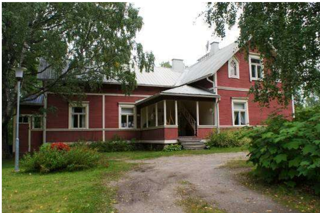
Kuva: Rauhaniemen huvila. Pihakuisti on uusittu.
