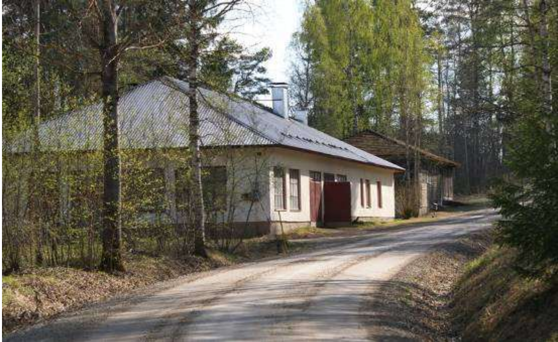
Kuva: Sahan alueella, vanhan portin paikan lähellä, on ryhmä 1950-luvun rakennuksia. Kuvassa on verstaas-, paja- ja asuntoholtotilat sekä asunnon käsittänyt rapattu rakennus sekä lautaseinäinen tarvikevarasto. Niiden taakse jää uudempi kaksikerroksinen rapattu konttorirakennus, jonka, mahdollisesti myös verstaan, suunnitteli mikkeliäinen arkkitehti Eero Jokilehto.
