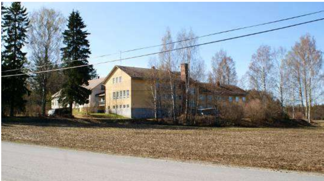
Kuva: Entinen Ristiinan kunnalliskodin päärakennus.
