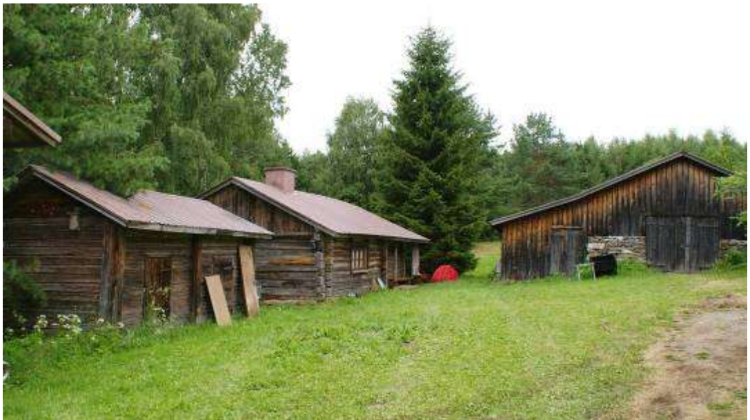
Kuva: Kylän kantataloihin lukeutuvan (Ylä-)Ollin pihapiiri on säilynyt poikkeuksellisen eheänä. Kaikkien rakennusten kattaminen pellillä vuosikymmeniä sitten on säilyttänyt välillä vähälläkin käytöllä olleen rakennusryhmän. Maalaamattomien hirsirakennusten rajaama pihakokonaisuus sisältää iäkkäistä aittoja ja maatalousrakennuksia sekä nyt peruskorjauksen alla olevan vanha matalan hirsitalon. Kuvassa pariaitta ja entinen lampola ja navetta.
