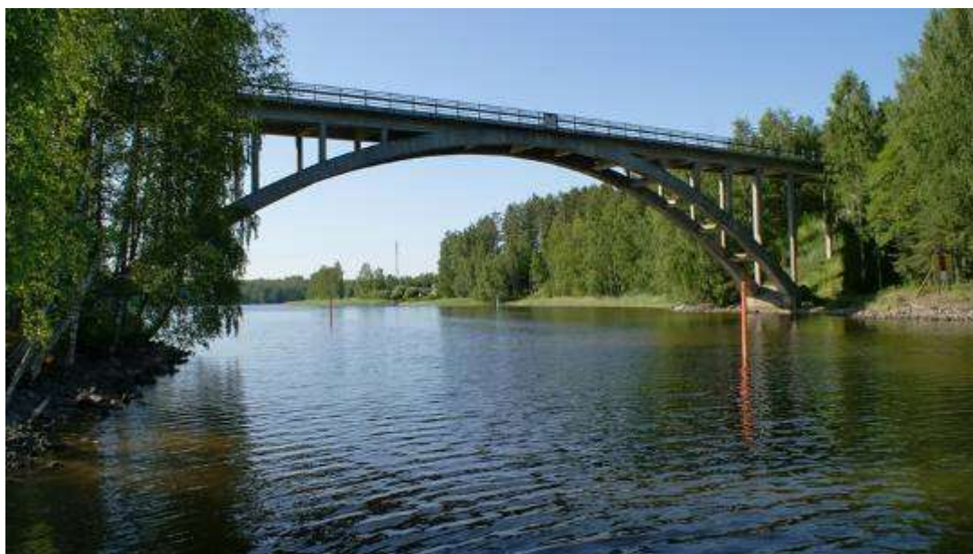
Kuva: Juurisalmen silta.
