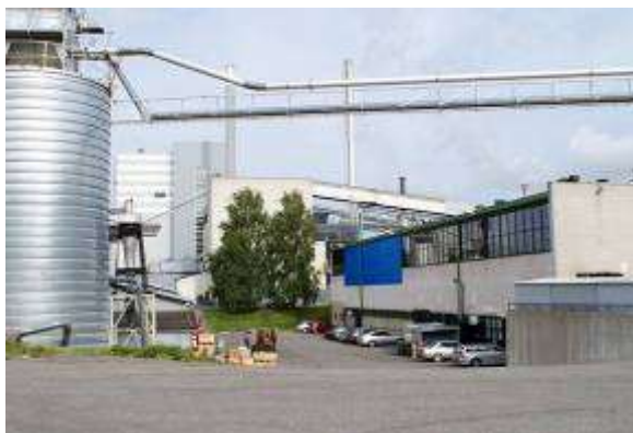
Kuva (vasen): Pelloksen uusi ja vanha voimalaitos ja korjaamo.
