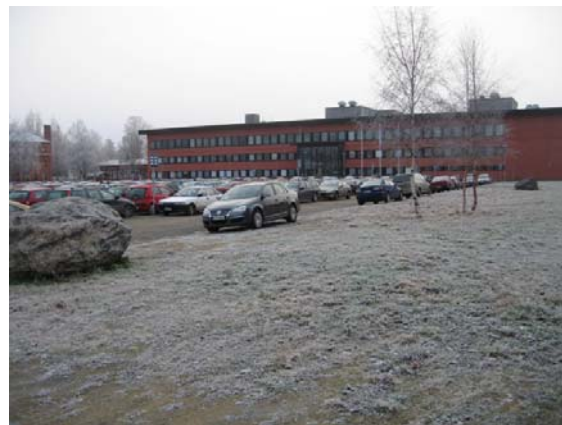
Kentän eteläpuolen rakennus korotettuna 3-kerroksiseksi.
