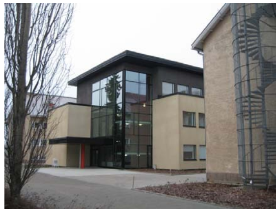
Syksyllä 2011 on kasarmirakennusten väliin kohonnut lisärakennus.
