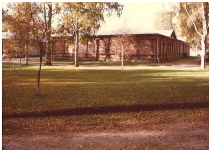
Puistokäytävän reunaa 1970-luvulla ennen peruskorjausta
