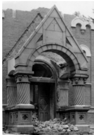
Kirkon purkutyöt käynnissä. (www.mikkeli.fi)
