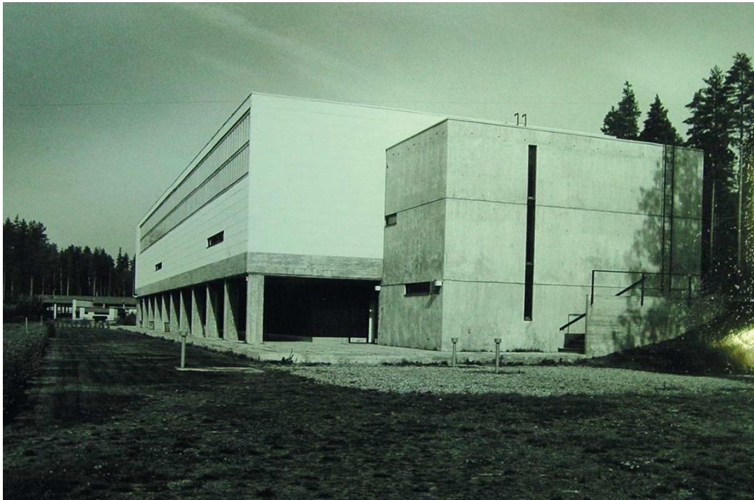
Kuva 14. Kuntotalo, rakennus 0017 vuonna 1976 (Kuva: Puolustusvoimien koulutuksen kehittämiskeskus, Pvk: Tuotanto-osaston kuva-ala, 1520/67)
