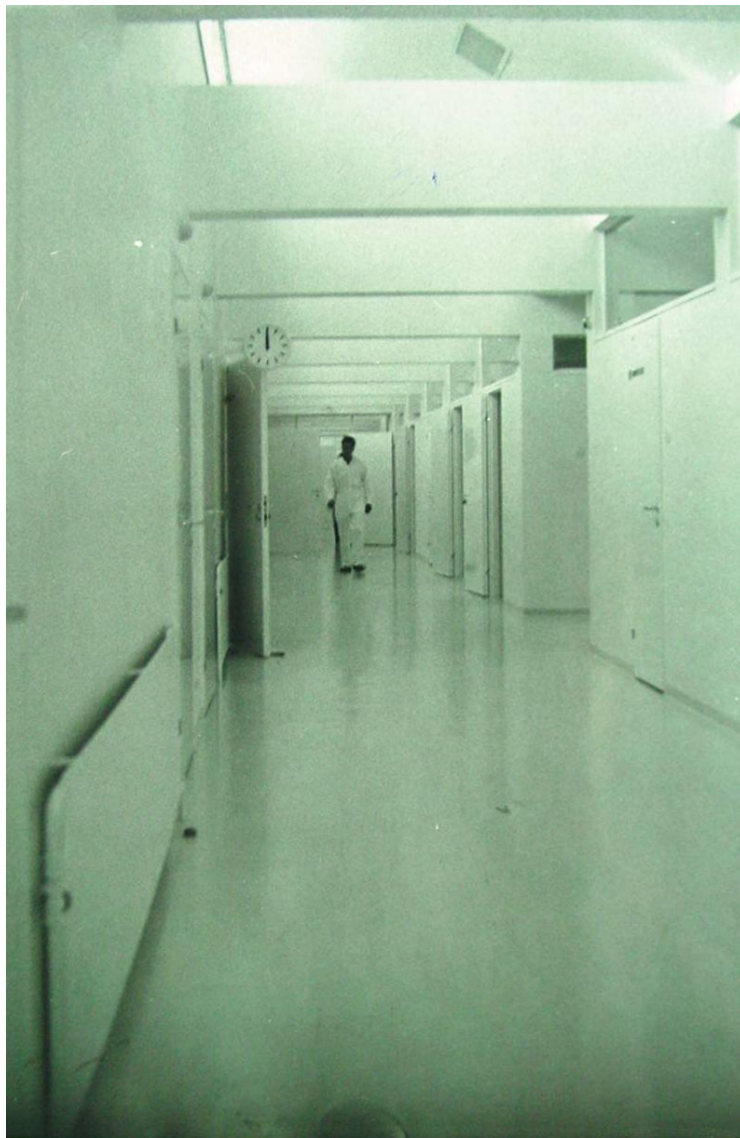
Kuva 12. Sairaalan käytävä, rakennus 0013 vuonna 1967 (Kuva: Puolustusvoimien koulutuksen kehittämiskeskus, Pvk: Tuotanto-osaston kuva-ala, 2365/67)
