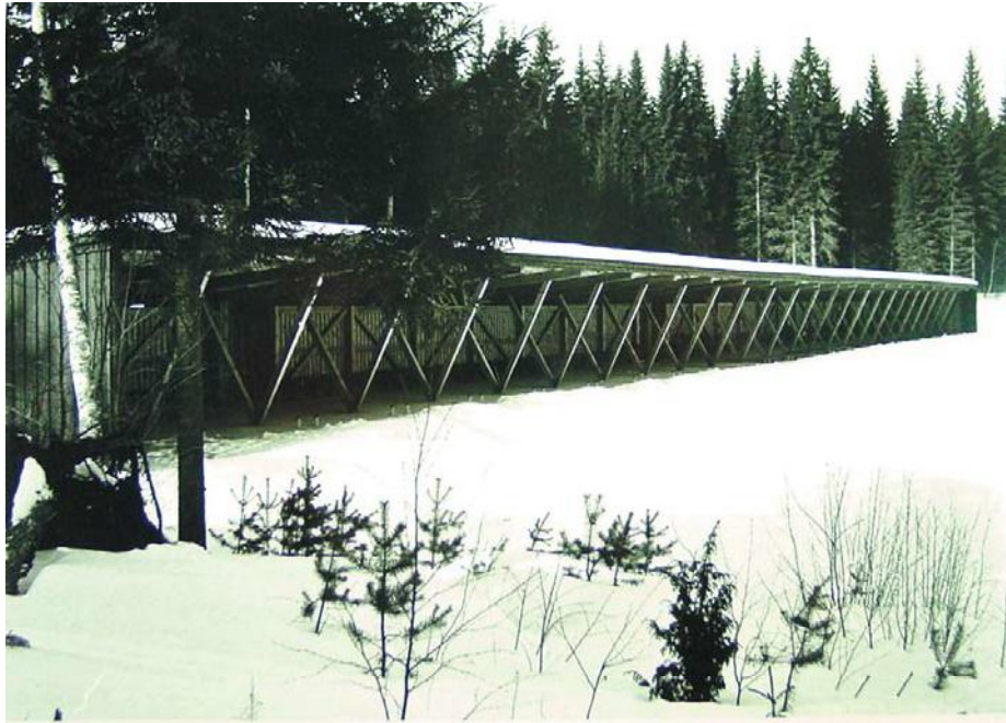
Kuva 13. Ampumaradan katos Kyrönpellon alueella v. 1983 (Kuva: Puolustusvoimien koulutuksen kehittämiskeskus, Pvk: Tuotanto-osaston kuva-ala, 566/83)
