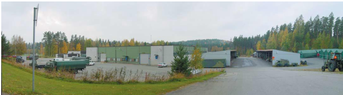
Kuva 16. Panoraamakuva ajoneuvo- ja varastoalueesta v. 2005 (Kuva: JP-Infra)
