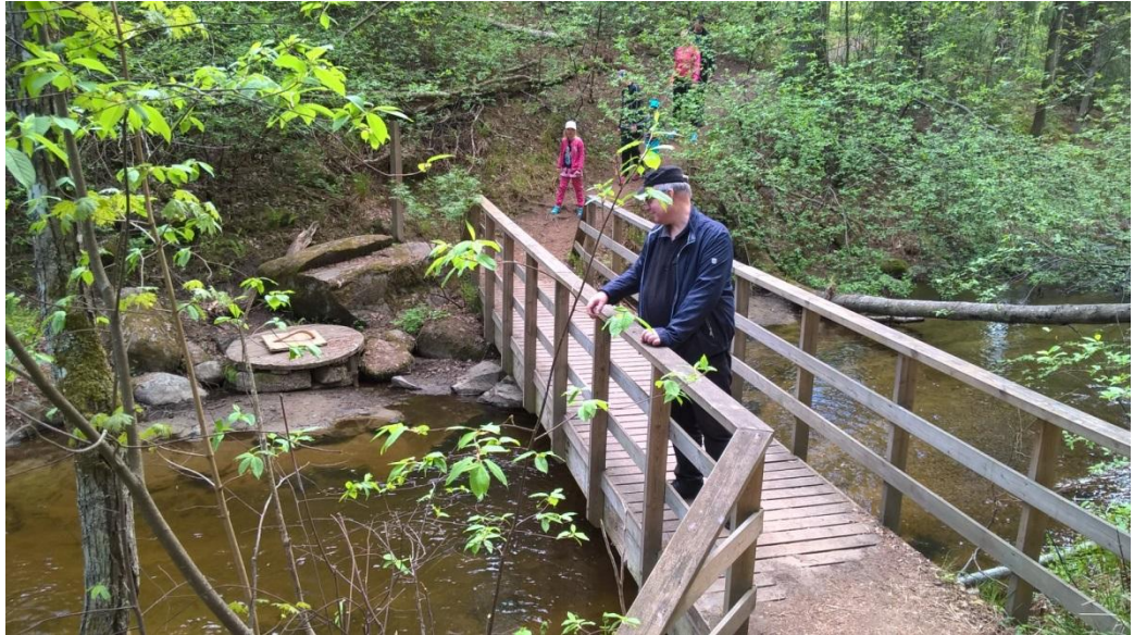
Kuva 9. Luontopolun rakenteisiin kuuluu mm. siltoja ja opastetauluja.
