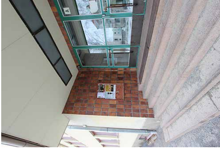
Kuva: Kuvassa pääsisäänkäynnin metallikehyksiset lasiovet, joissa alkuperäiset ovenkahvat ovat säilyneet. Sisäänkäyntisyvennyksen seinät ovat verhoiltu laatoilla.
