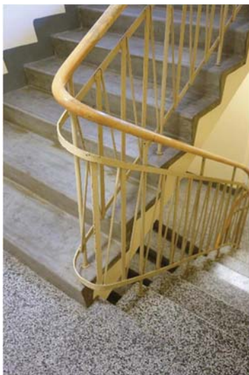
Juhlasalisiiven länsipäädyn porrashuoneessa on alkuperäiset metalliset pinnakaiteet.
