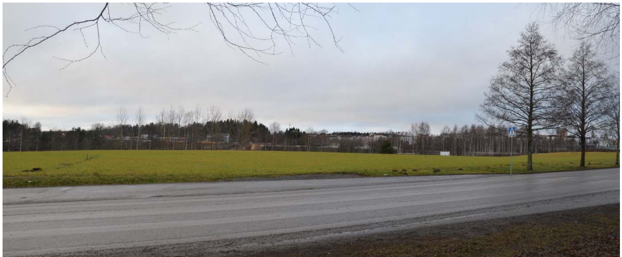
Kenkäveronniemen valtakunnallisesti arvokasta rakennettua kulttuuriympäristöä, joka taustamaiseman osalta on levoton. Alue itsessään on vehreä ja viihtyisä miljö. Taustalla näkyy valtatie 5 työmaa ja kaupungin silhuetti. Räinen, K
