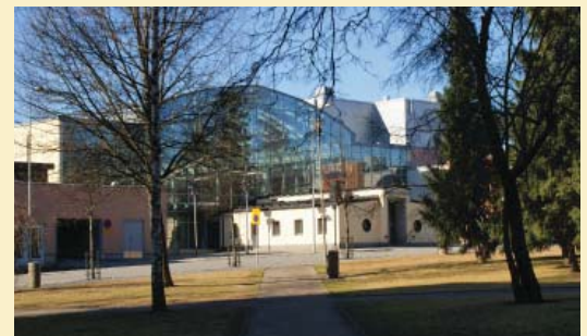
Yläkuvasa Hallitustorin pohjoisjulkisivu, josta erotuvat Stellan porttirakennukset. Alakuvasa Stellan julkisivu Kirkkopuiston suuntaan. (Yläkuva: Mikkelin kaupunkisuunnittelun arkisto. Alakuva: Teija Ahola)
