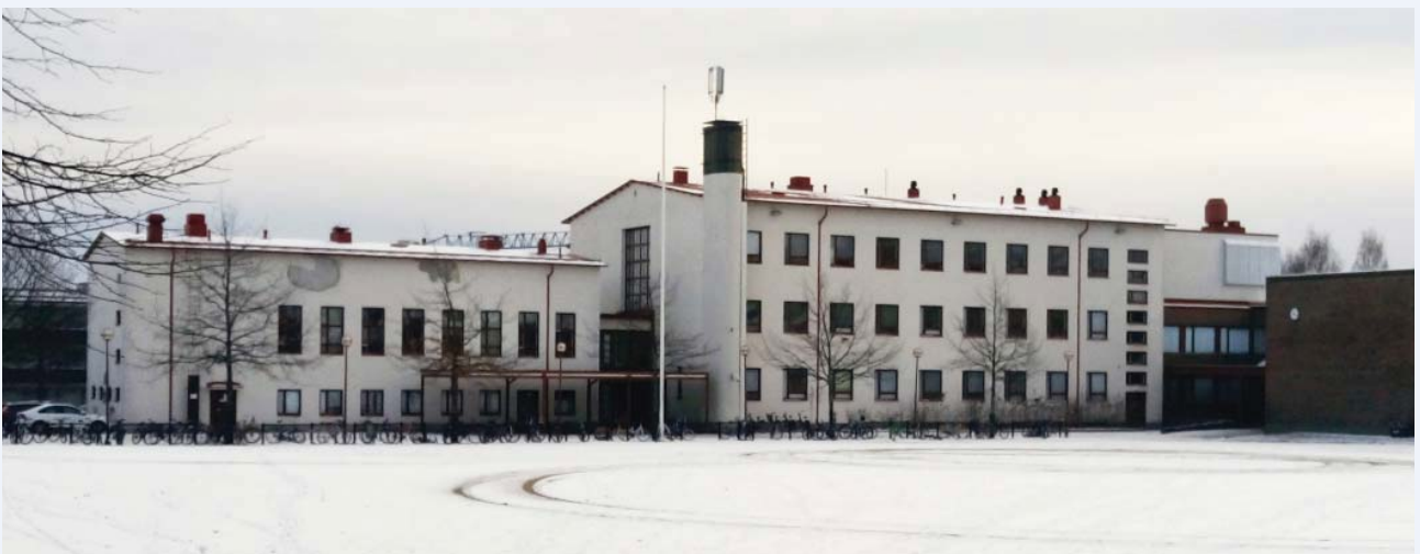
Martti Välikankaan suunnittelema rakennuksia Mikkelin keskustassa ovat muun muassa Vilhonkadun asuinrakennus 1930-luvulta (vasen yläkulma), Urheilupuiston kioski (oikea yläkulma) sekä Mikkelin lyseo (alin kuva). (Mikkelin kaupunkisuunnittelun valokuvat)
