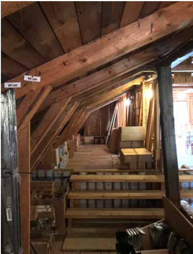
Uudemman rakennusosan kattotuolit. Kahden rakennusosan raja kulkee portaan kohdalla olevan seinän kohdalla.
