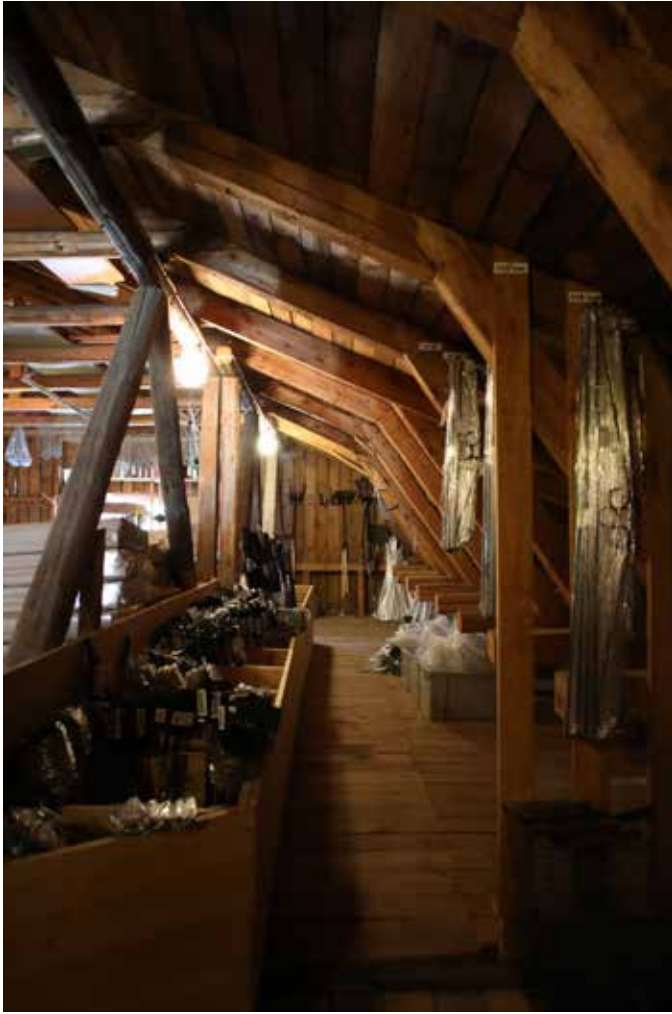
Vintillä kattotuoleissa ja muissa hirsirakenteissa on nähtävillä lukuisia aikakerrostumia.
