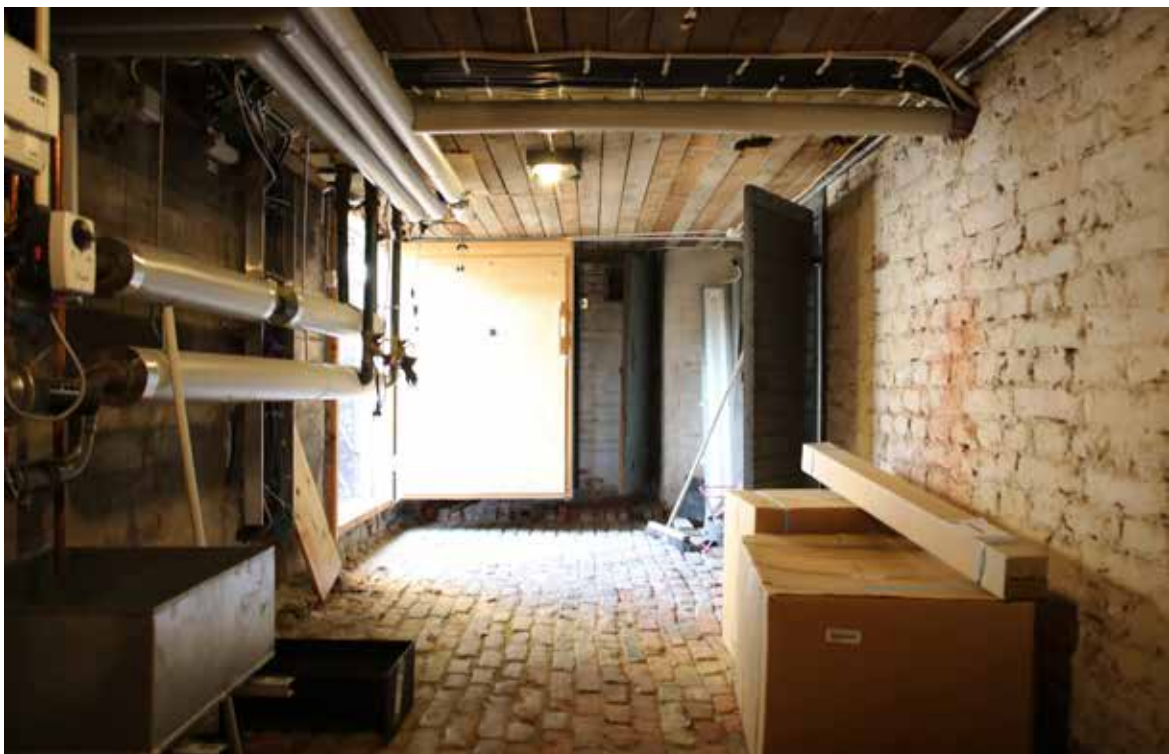
Kellarin muuratut osat lienevät peräisin rakennuksen alkuvaiheilta.
