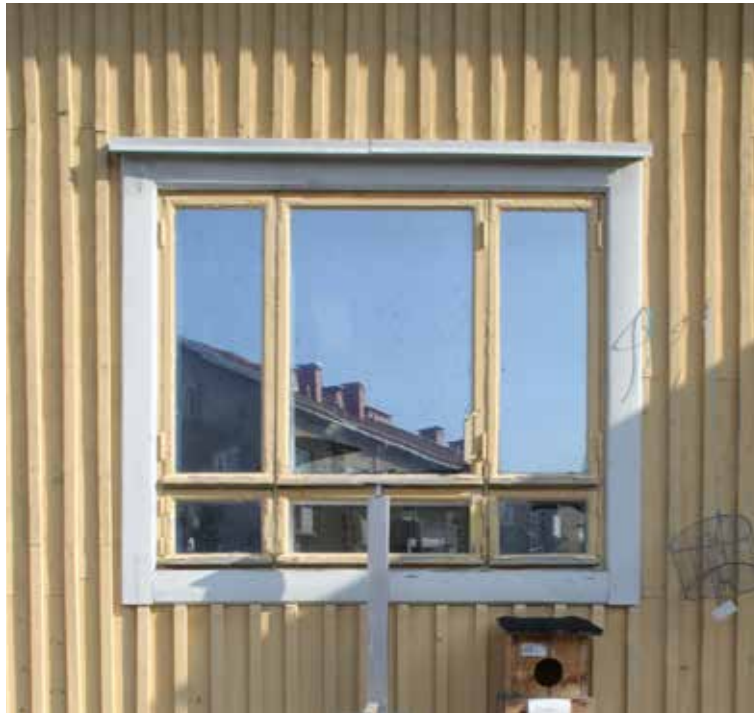
Alakerrassa esiintyy kahta ikkunatyyppiä. Isompi on kuusiruutuinen. Alaosan vaakapuite on 30-luvulle tyypillinen yksityiskohta.
