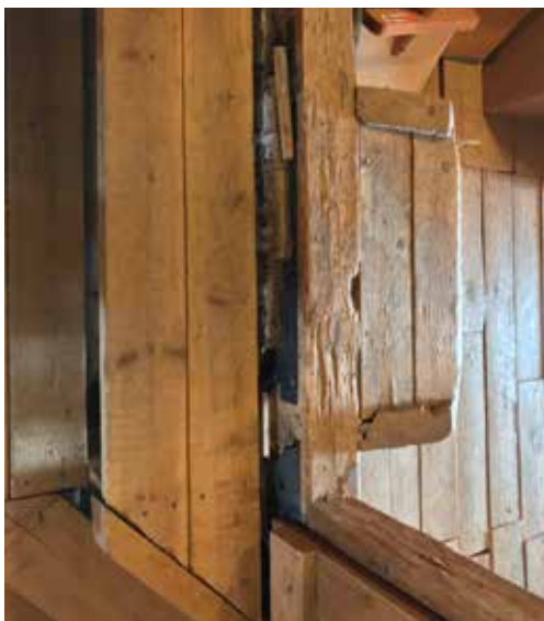
Vintin lattia on korotettu uuden rakennusosan kohdalla.
