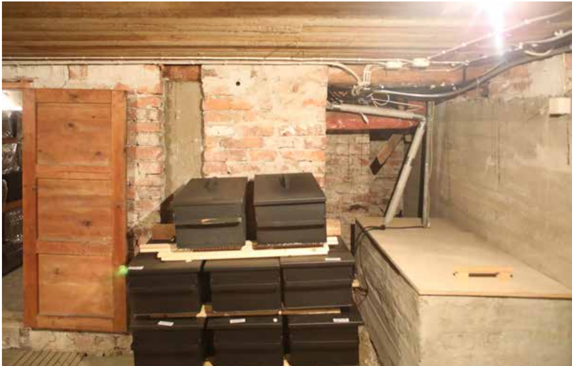
Myös kellarin rakenteissa ajallisia kerrostumia on nähtävissä.
