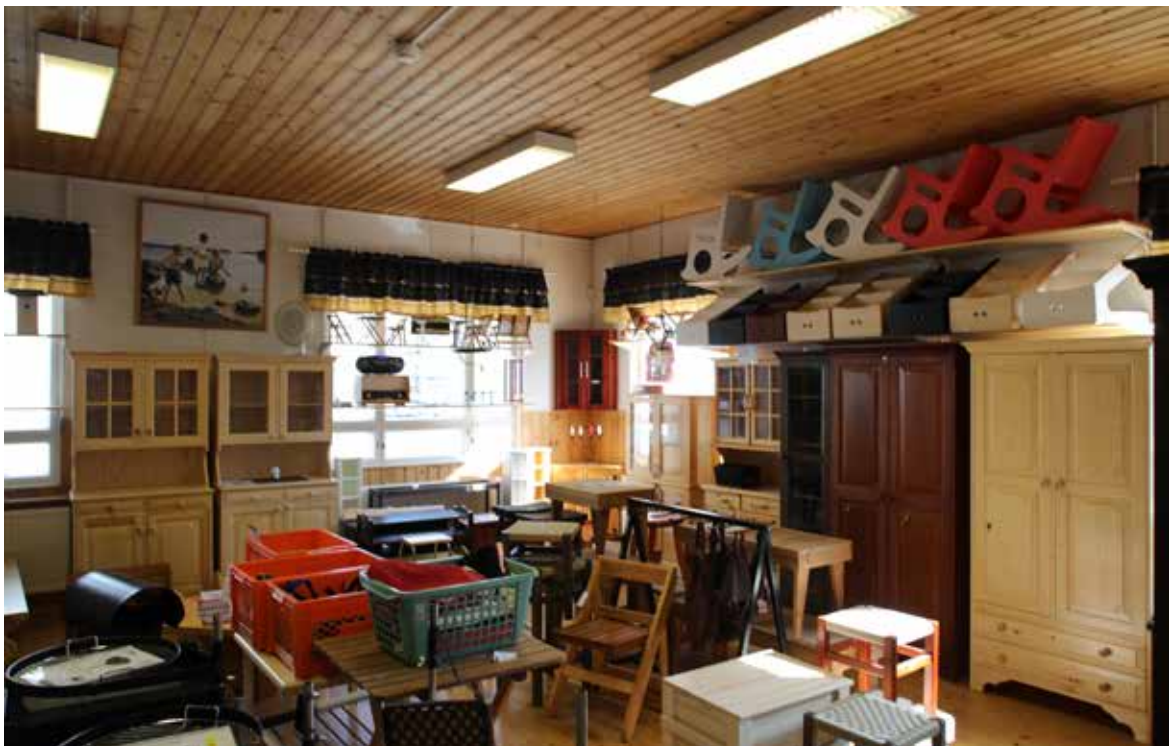
Itäpäädyn myymälätiloissa on lankkulattiat sekä laudoitetut sisäkatot.
