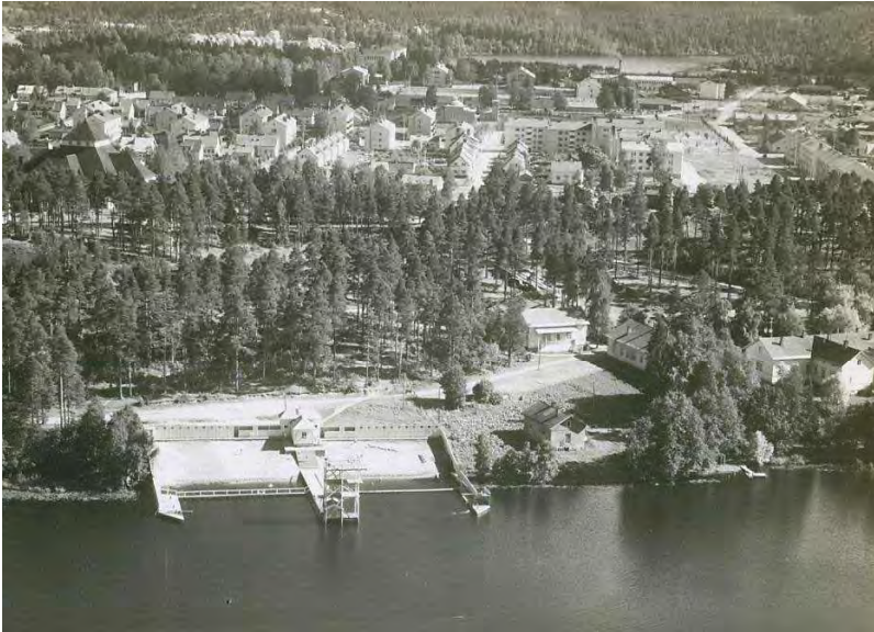
Kuva: Rakennukset vasemmalta oikealle: Pankalammen Uimala ja vanhainkodin sauna, purettu C-rakennus, B- ja A-rakennukset. / Viistokuva vuodelta 1961 © Veljekset Karhumäki (julkaisulupa)
