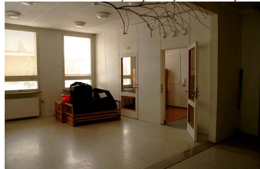
Kuvat: B-rakennuksen huonetiloja on yhdistetty väliseiniin tehdyin aukoin.
