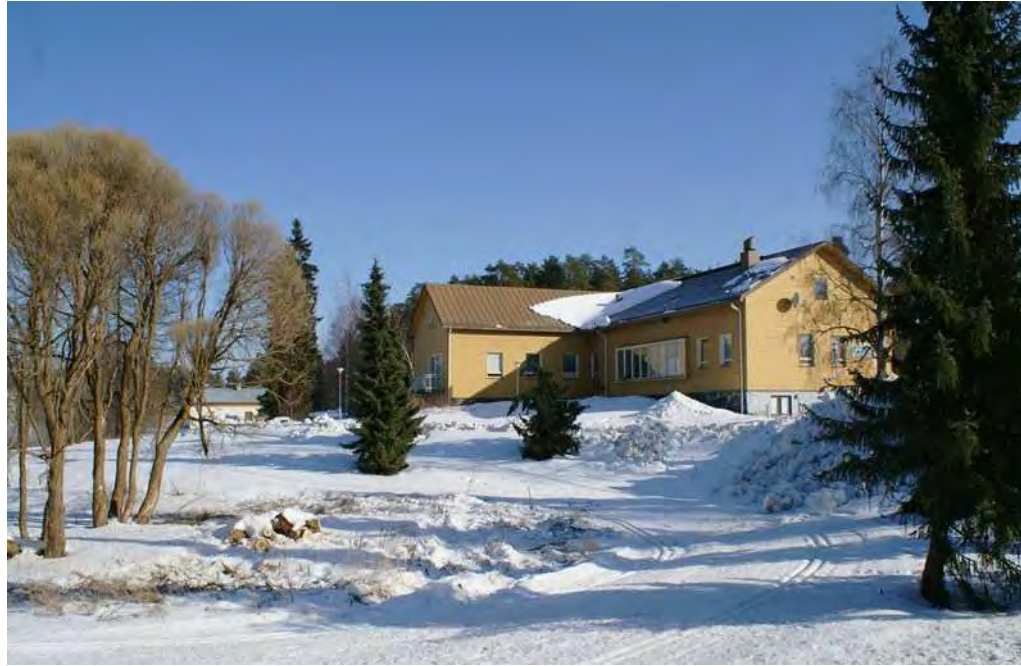
Kuva: A-rakennus kuvattuna Saattotieltä.
