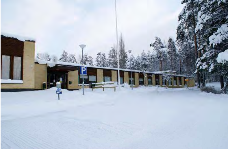
Kuva: Rakennuksen pääsisäänkäynti katoksineen sulautuu osaksi talon julkisivujen rytmiiikkaa.
