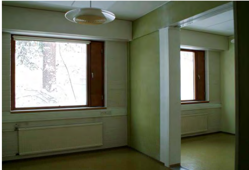
Kuva: Asuntosiiiven kapeita huoneita, jotka on myöhemmin yhdistetty isommaksi tilaksi väliseinään puhkaistulla aukolla.
