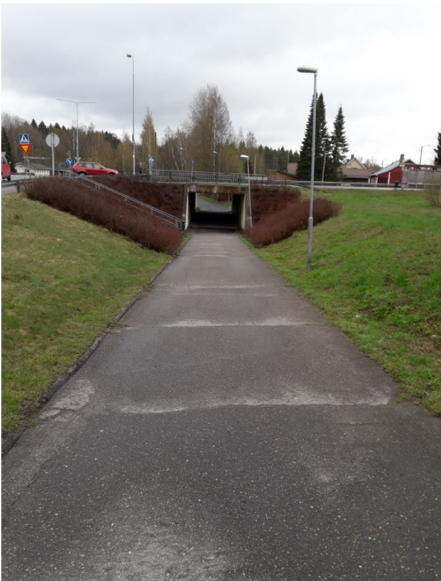
Juvantien alikulku, kuvattuna Peitsarinkujalta.
