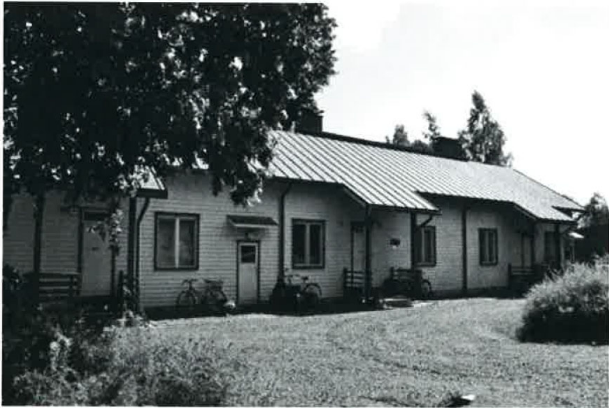
Kuva 4. Pajakadun rivitalon julkisivua (kuva rakennusinventointi).
