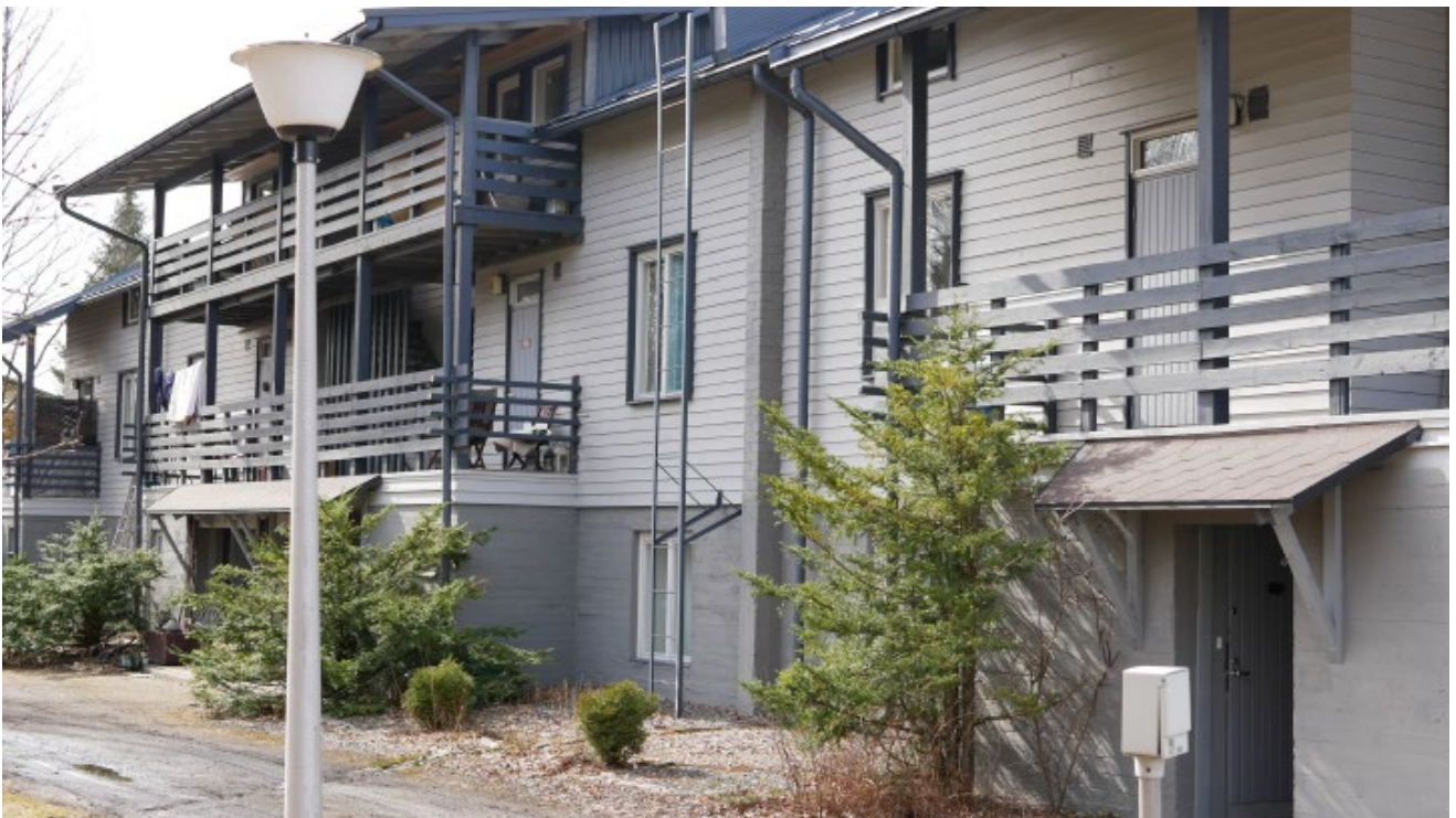
Pajakadun julkisivua pihan puolelta.
