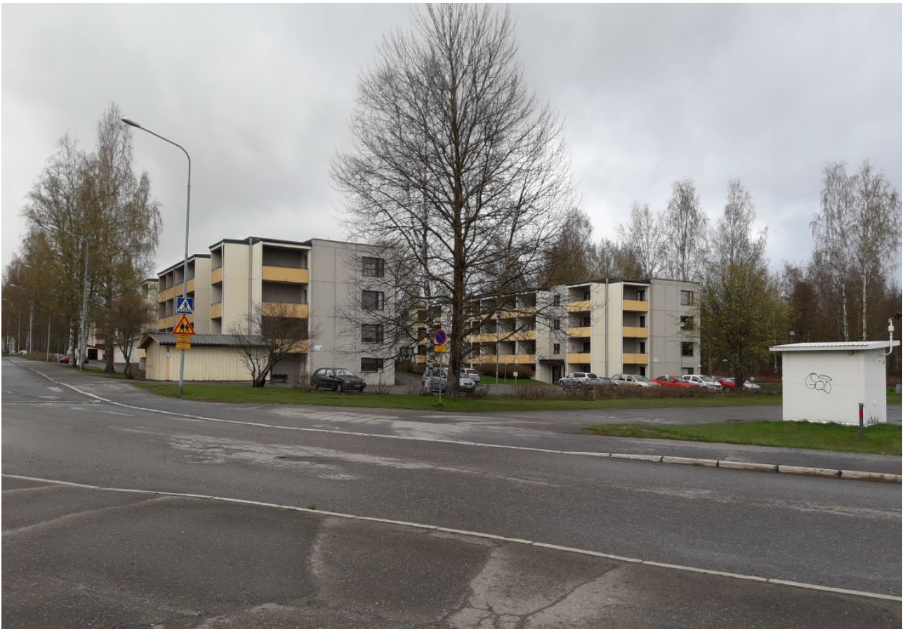
Kylmäaseman takana olevaa kerrostalomassaa, kuvattuna Peitsarinkujalta.
