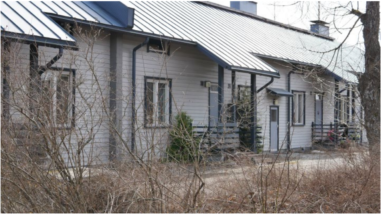
Rakennuksen julkisivua Pajakadun suunnasta.
