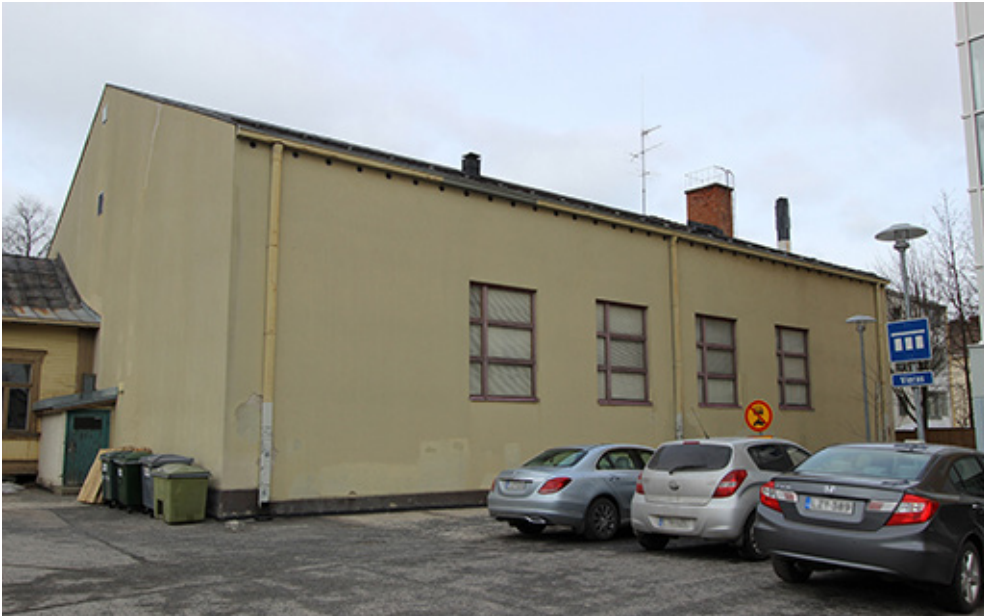
Kuva: Urheilutalon sisäpihan puoleinen julkisivu. Liikuntasalin korkeat ikkunat ovat säilyttäneet alkuperäisen muotonsa, vaikka niihin on tehty muutoksia vuonna 1982.
