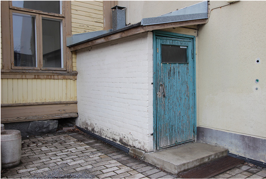
Kuva: Kellarikerroksen varauloskäynti on rakennettu 1958.
