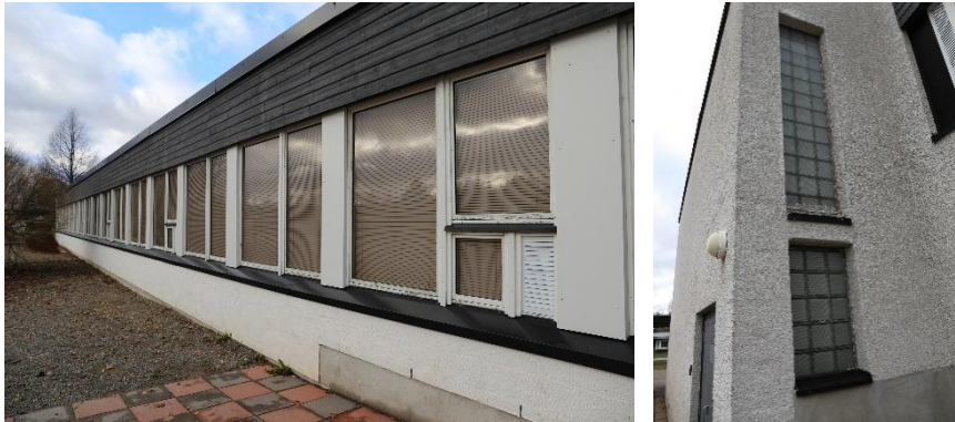
Koulun ikkunat ovat pääosin 1980-luvulta. B-siiven porrashuoneessa on käytetty lasitiiltä.
