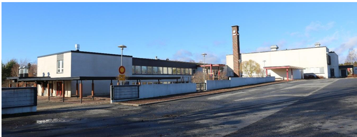
B- ja D-siipien julkisivut. Etualalla näkyy 1980-luvulla rakennettu sadekatos sekä koulun saattopiha, joka on erotettu välituntipihasta betonimuurilla.
