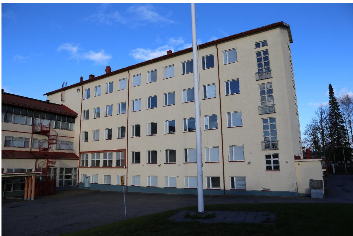
Luokkahuonesiiven länsijulkisivusta erottuvat ruokalan ikkunarivi sekä eteläpäädyn porrashuone.
