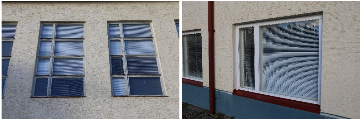
Vasemalla on juhlasaliin vanhat ikkunat ja oikealla luokahuoneisiin uudet ikkunat.
