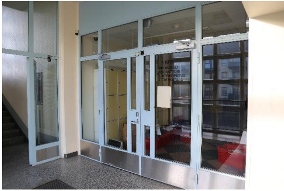
Porrashuoneissa ja oppilaskäytävillä on metallirakenteiset väliovet. Kuvassa eteläinen porrashuone.
