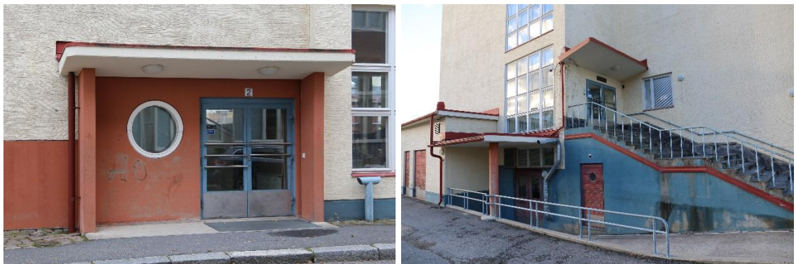
Vasemalla on Suur-Savonkadun puoleinen 1990-luvun lopulla rakennettu sisäänkäynti ja oikealla alkuperäinen sisäänkäynti Anni Swaninkadun puolella.
