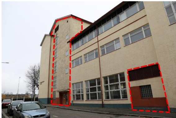
Julkisivusaneerauksen yhteydessä pohjoinen julkisivu koki merkittäviä muutoksia, kun hissien rakentamisen yhteydessä rakennusosaa laajennettiin pohjoiseen ja julkisivun sisäänkäynti siirtyi hissien yhteyteen.
