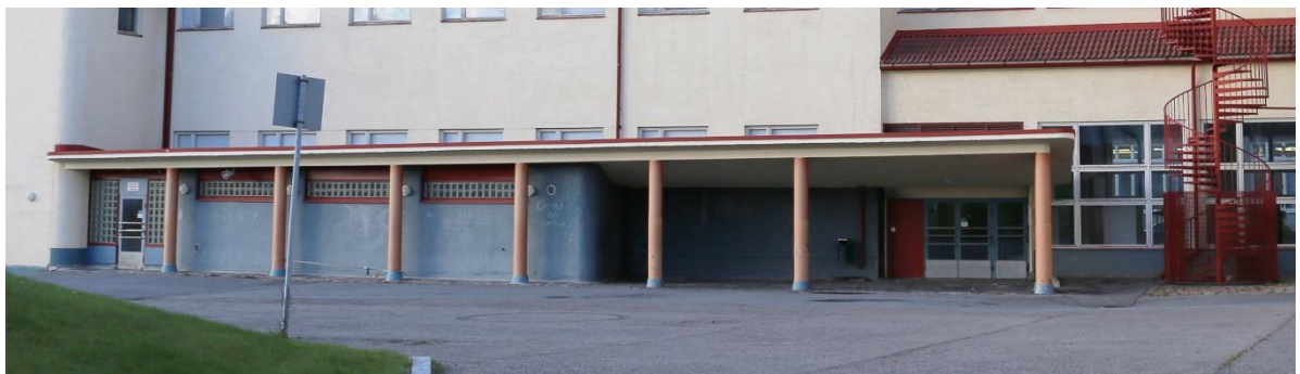
Pääsisäänkäynti jää pitkän sisäänkäyntikatoksen varjoon. Katoksen yhteyteen rakennettiin 1997 voimisteluvälinevarasto.
