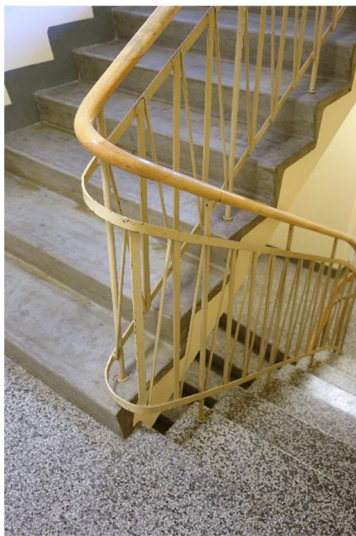
Juhlasalisiiven länsipäädyn porrashuoneessa on alkuperäiset metalliset pinnakaiteet.
