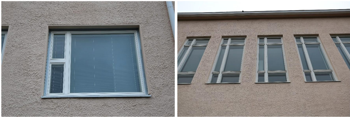
Vasemmalla on luokkahuonesiiven uusittu ikkuna ja oikealla on juhlasalisiiven vanhat ikkunat.
