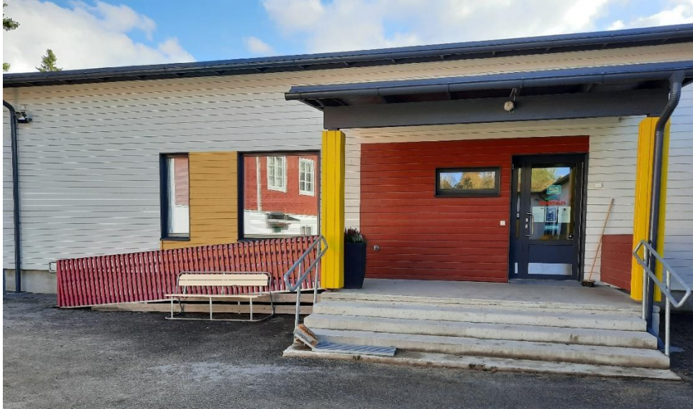
Kuva 11. Monista tarkastelluista portaista puuttuvat kontrastiraidat ja käsijohteet eivät jatku riittävän pitkälle portaan yli. Kuvassa Naisvuoren päiväkodin Revontulien sisäänkäynti.
