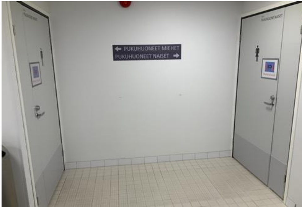
Kuva 13. Monet opasteista on sijoitettu heikkonäköisen kannalta hankaliin paikkoihin. Harmaan opasteen vaalea teksti ei ole kontrastiltaan riittävä. Kuvassa Naisvuoren uimahallin pukuhuoneiden opasteet.
