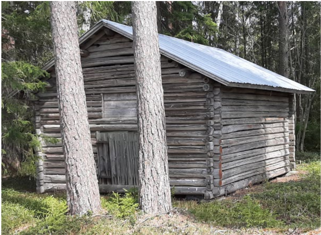
Simpukkaranta, alueella oleva hirsinen varistorakennus, n. 20 m2.
