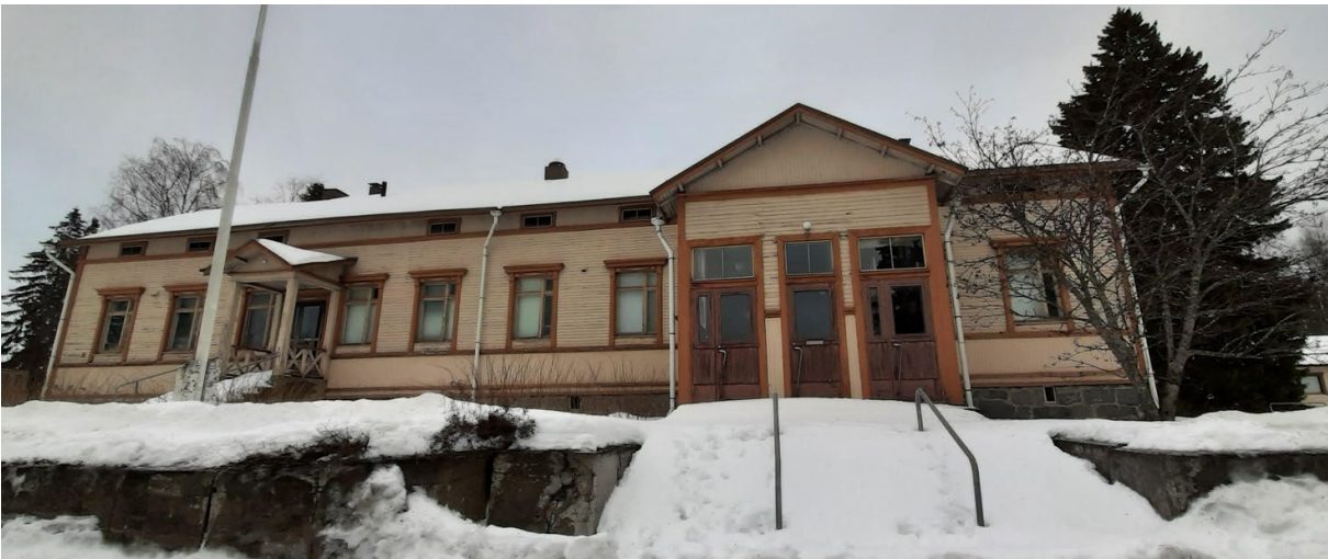
Kuva 3. Ristiinan entinen kunnantalo Linnantieltä / lännestä kuvattuna.
