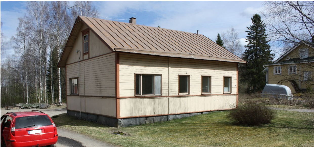
Kuva 6. Näkymä Linnantieltä, Osulan rakennus
