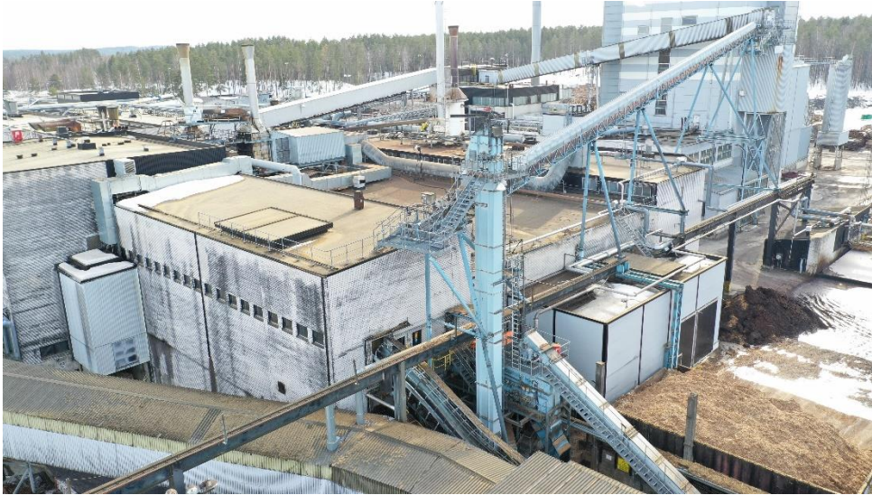
Kuva 11. Pello 2 ja näkymä prosessilaitteiston rakennelmien kytkeytymisestä rakennukseen osana modernisaatiota.
