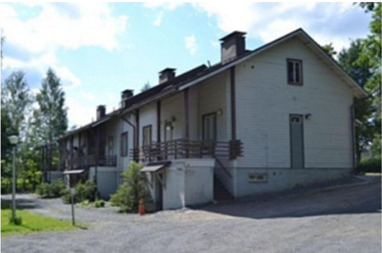
Kuva 12. Pajakadun rivitalon julkisivua pihan puolelta (kuva rakennusinventointi).
