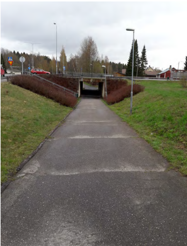
Juvantien alikulku, kuvattuna Peitsarinkujalta.
