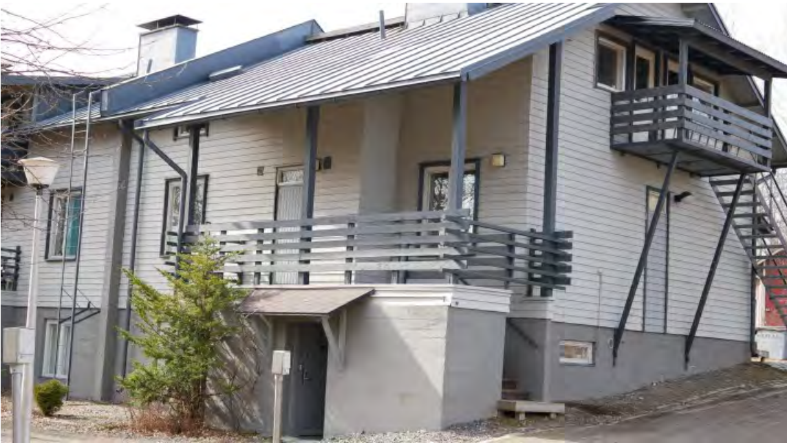
Pajakadun päässä sijaitsevan kaupungin ensimmäisen puurivitalon julkisivua ja päätyä.
