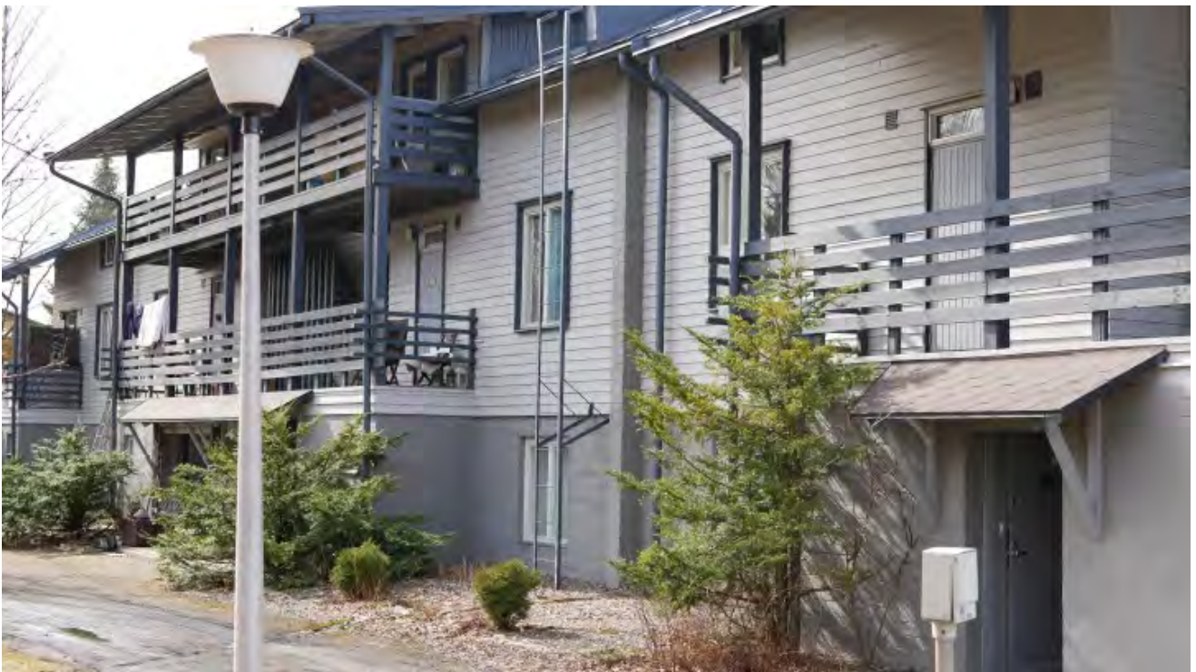
Pajakadun julkisivua pihan puolelta.
