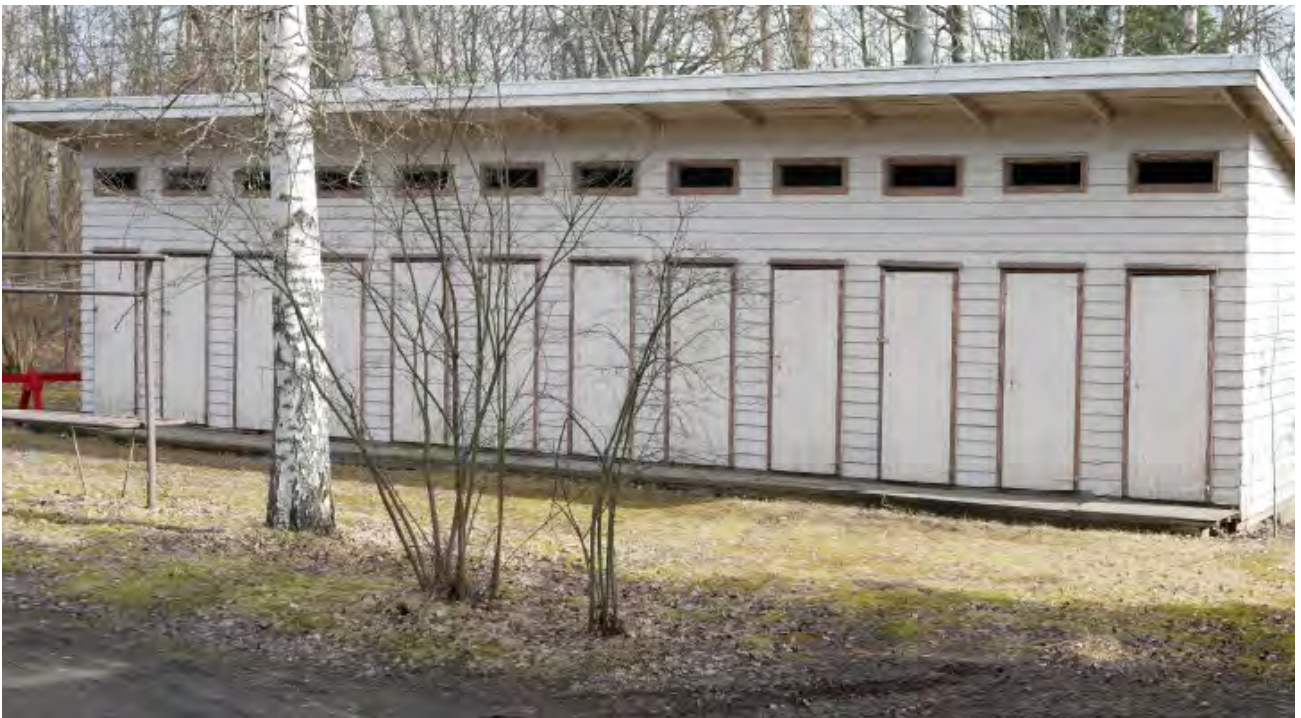
Pajakadun rivitalon pihavarasto.
