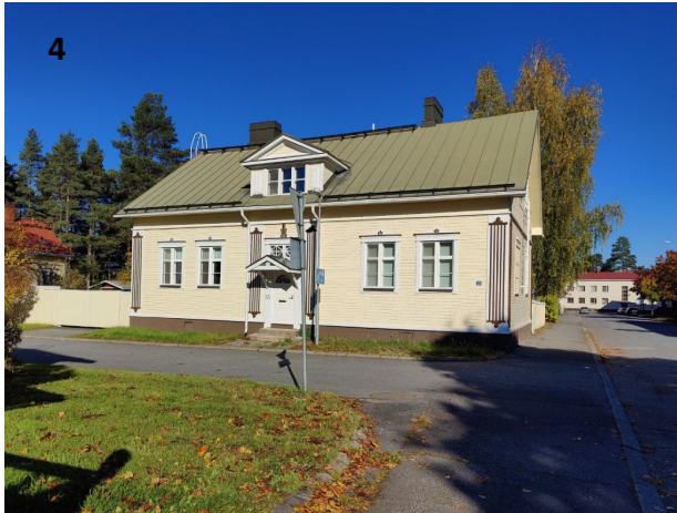
Kohde 4. Klassistisia piirteitä omaava asuinrakennus 1930-luvulta. Kulttuurihistoriallisesti merkittävä, kohteella on rakennushistoriallisia, historiallisia ja maisemallisia arvoja.
