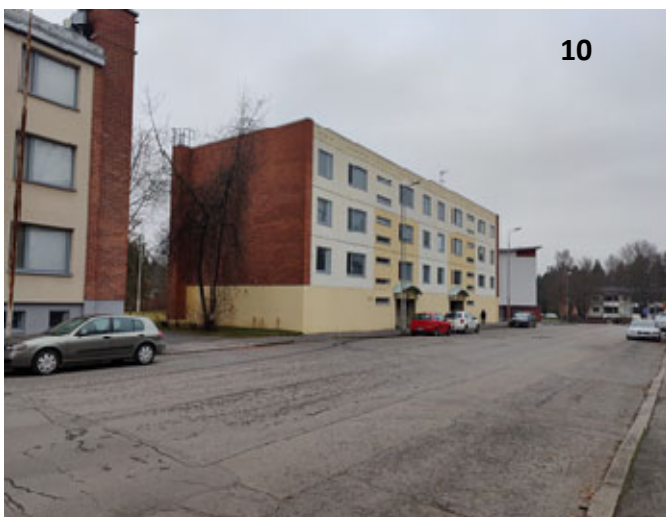
Kohde 10. Suunnittelualuetta vastapäätä Pietarinkadun puolella osoitteessa Pietarinkatu 22 sijaitseva kerrostalo on valmistunut vuonna 1970.
