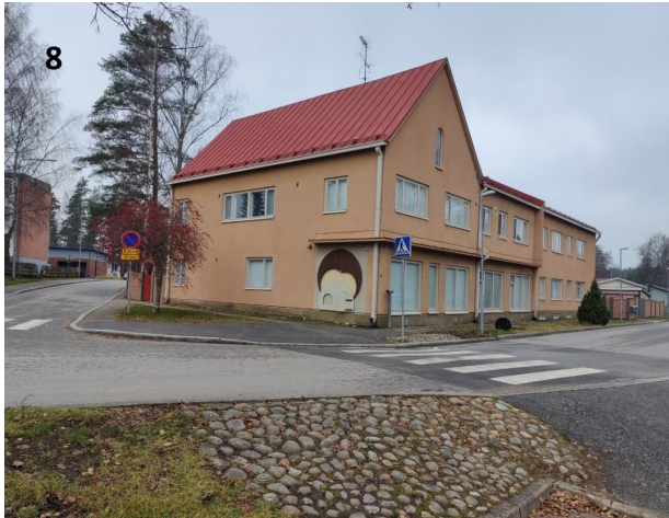
Kohde 8. 1940-luvulla uuden asuinalueen lähelle rakentunut Kulutusosuuskuntien keskusliiton arkkitehtiosaston suunnittelema liikerakennus.
