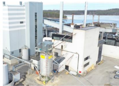
5. Vanha voimalaitos (matala osa) kytkettynä uuteen voimalaitokseen
