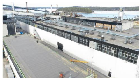
Vanhan osan julkisivu
