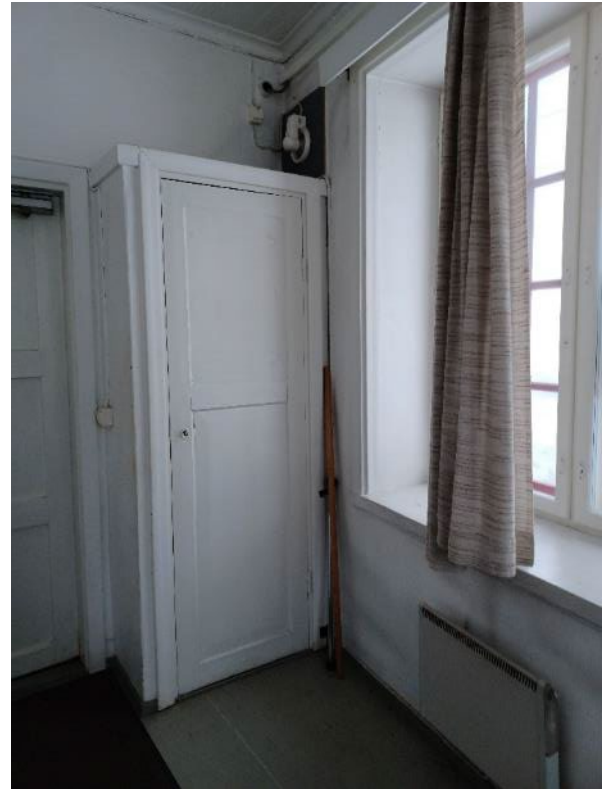
Kuva 67. Ala-aulan seinät on päällystetty Enso-pahvilla. Väliovet ovat alkuperäisiä.
