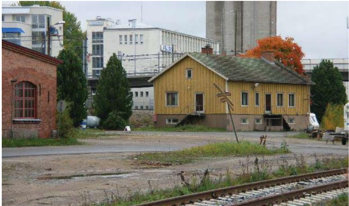
Kuva 16. VR:n vuonna 1951 rakennettu huoltorakennus (Petri Enqvist, 2006)
