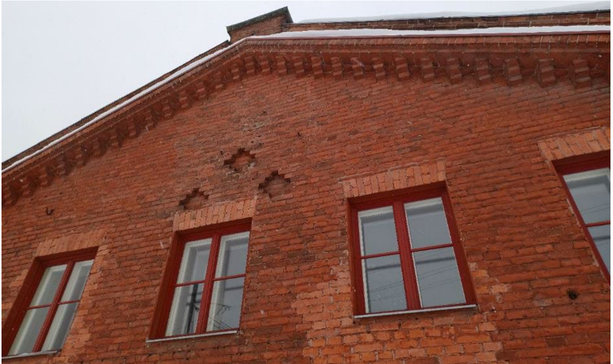
Kuva 56. Toimistopäädyn ikkunoita länteen päin.
