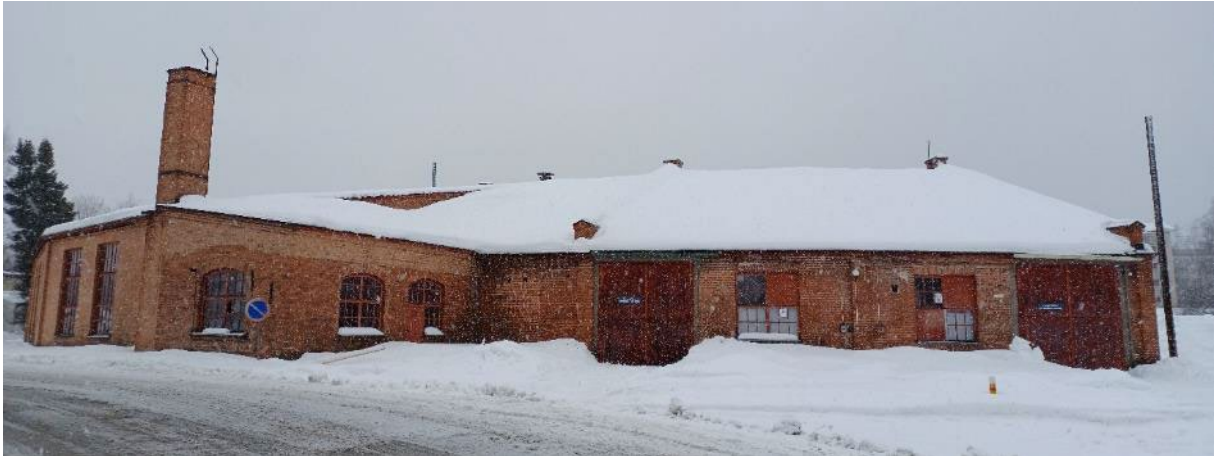
Kuva 33. Rakennuksen idänpuoleinen julkisivu.
