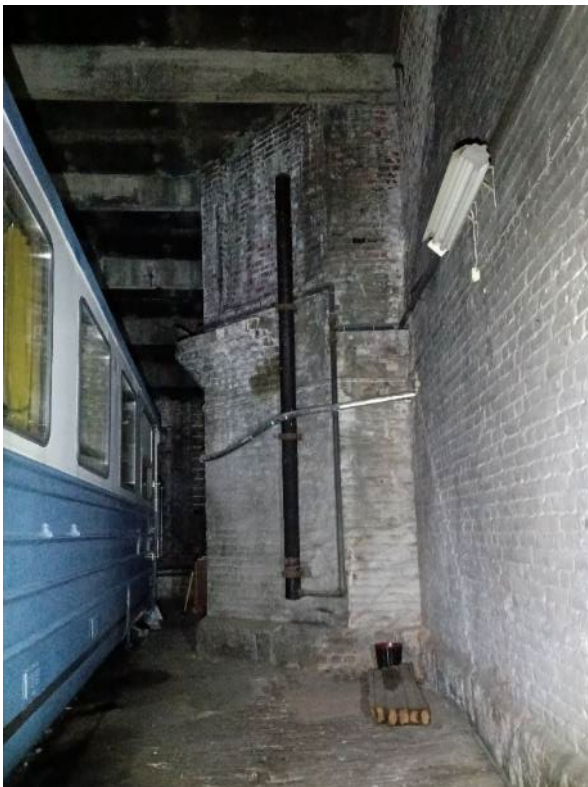
Kuva 90. Tilan 8 seinäpintaa, edessä vesitorni.
