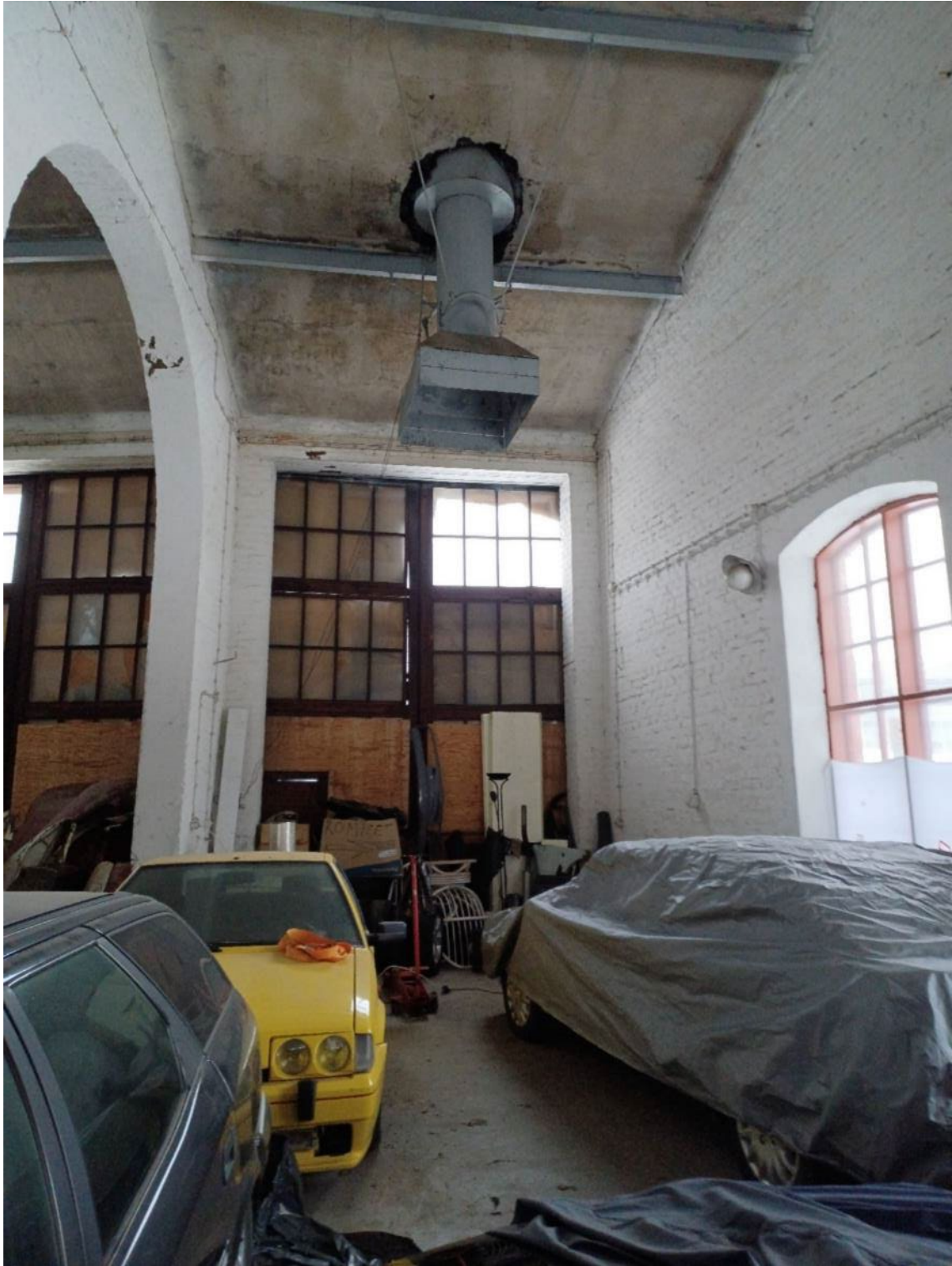
Kuva 105. Tilassa on betonilattia ja tiiliseinät. Puisten, alkuperäisen mallin mukaisten tallinovie (1 ja 2) suuret, moniruutuiset ikkunat on peitetty vanerilla ilkeivallan vuoksi. Ikkunoiden sisäpuutteet vaihdettu 1-ruutuisiksi. Pyöreät valaisimet todennäköisesti alkuperäiset, ja toimivat edelleen.
