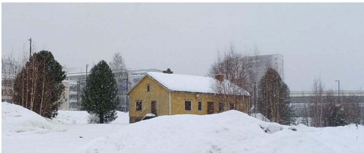
Kuva 23. Entinen huoltorakennus veturitallien pohjoispuolella.
