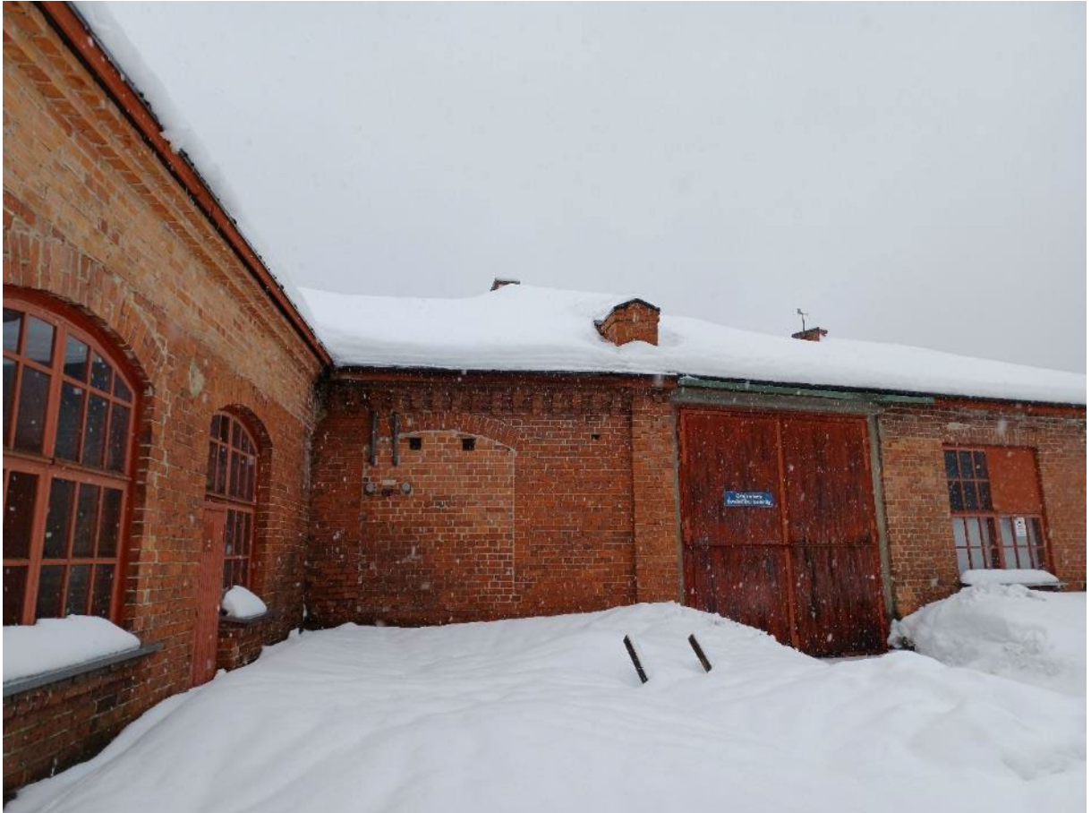
Kuva 55. Kuvassa pohjoispäädyn tilan toinen takaovi. Umpeen muuratun ikkunan takana on ollut öljysäiliö. Nämä sekä vasemmalla näkyvät ruutuikkunat ja ovi (nro 13) kuuluvat rakennuksen vuoteen 1913 mennessä rakennettuun osaan.
