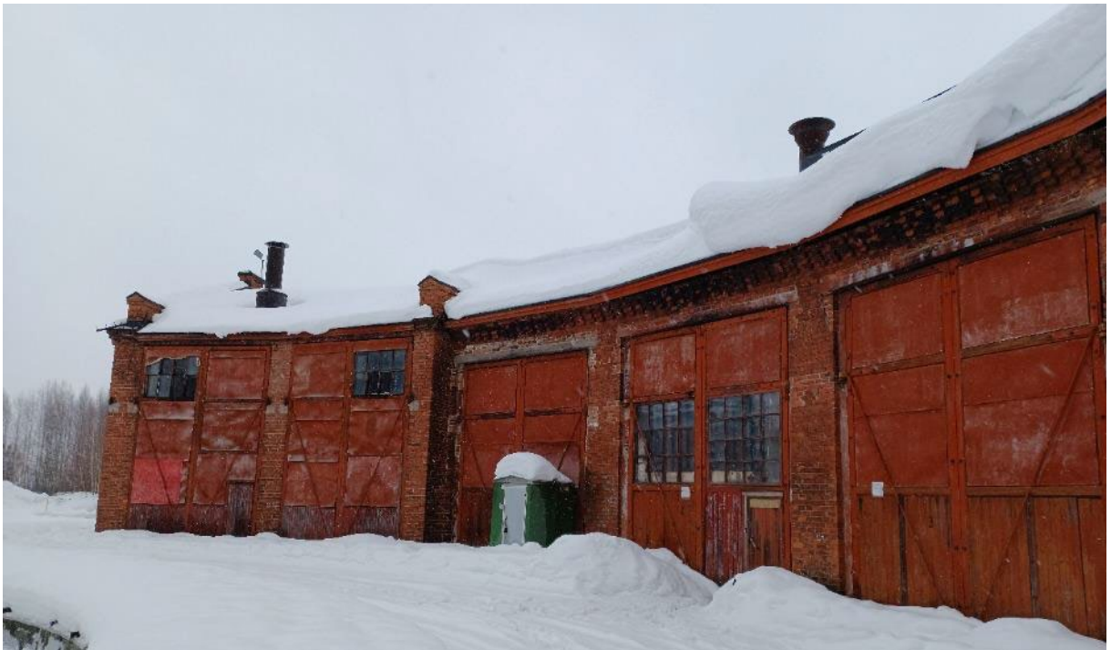
Kuva 34. Sisäpihaa kääntöpöydän vierestä kuvattuna. Rakennuksen pohjoispäädyn tilat 1–4.
