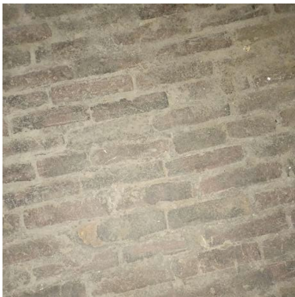
Kuva 75. Lattia on ladottu punatiilistä.
