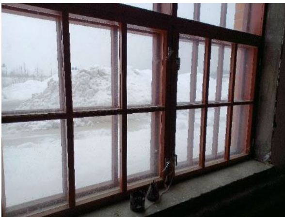
Kuva 99. Ikkunat ovat uusitut. Vain alimmaisissa puitteissa on 6-ruutuinen jako.
