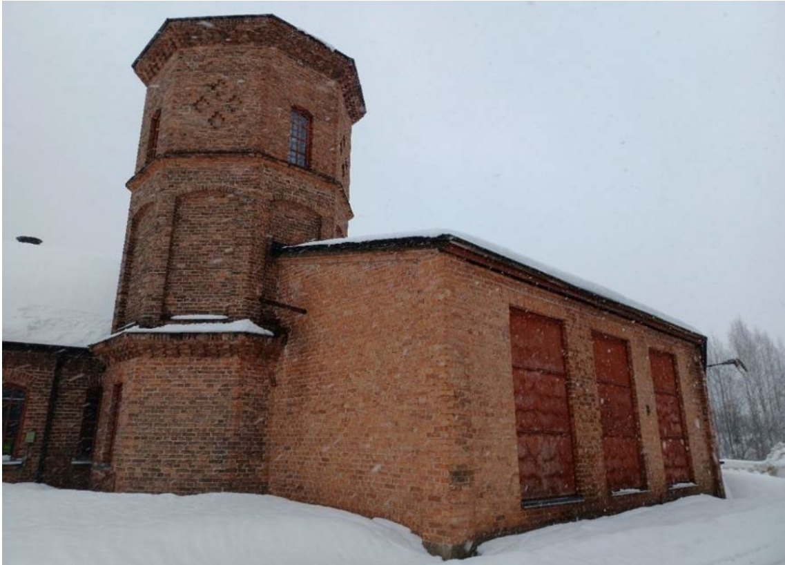
Kuva 42. 1880-luvun vesitorni ja 1940-luvun laajennusosa.
