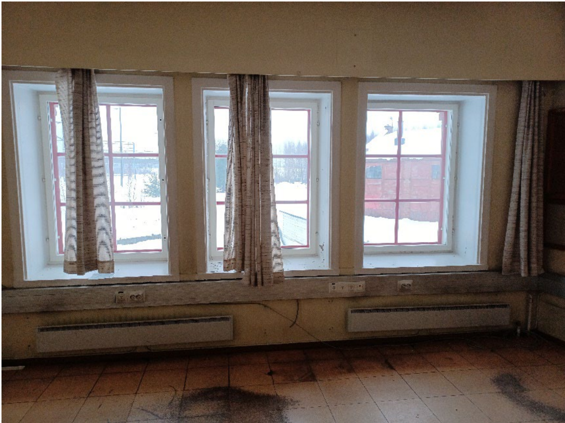
Kuva 71. Isompi toimistohuone, jonka ikkunat ovat sisäpihalle päin.
