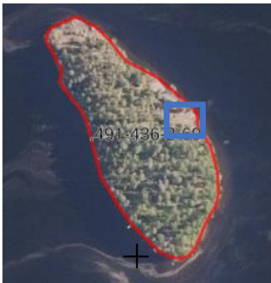
Kilpuinsaari. Purettavan rakennuksen sijainti. Ilmakuvat suunnittelualueista.
