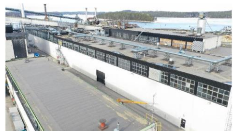
Vanhan osan julkisivu
