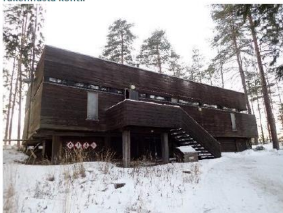
Kuva 3. Rakennuksen itäsivu. Koilliskulmalla noin 2 metrin etäisyydellä rakennuksesta kasvaa suurikokoinen mänty (kuvassa oikealla).
