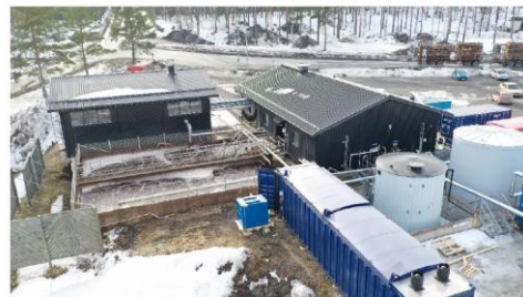
13. Jäteveden puhdistamo (oikeanpuoleinen rakennus)
