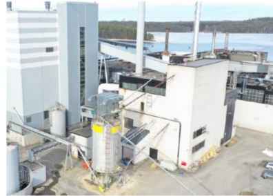
5. Vanha voimalaitos (matala osa) kytkettynä uuteen voimalaitokseen
