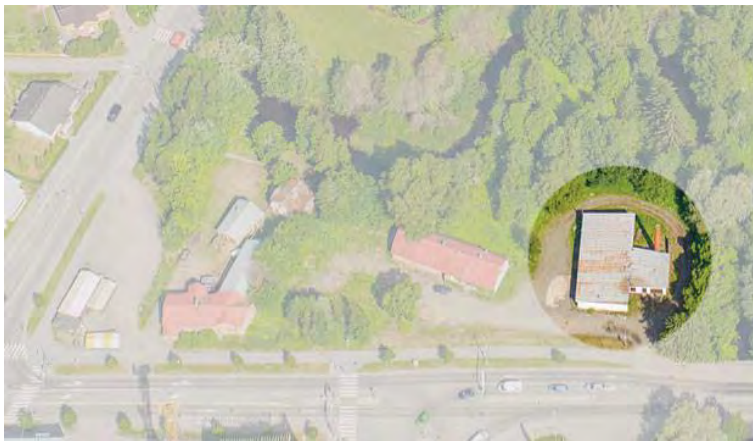
Meijerirakennuksen sijoittuminen viistoilmakuvassa. (Viistoilmakuva Mikkelin kaupunki)
