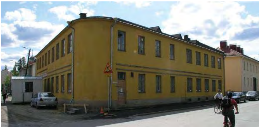
Vanha kenkätehdas ennen muutostöitä 2010. (Esku)
