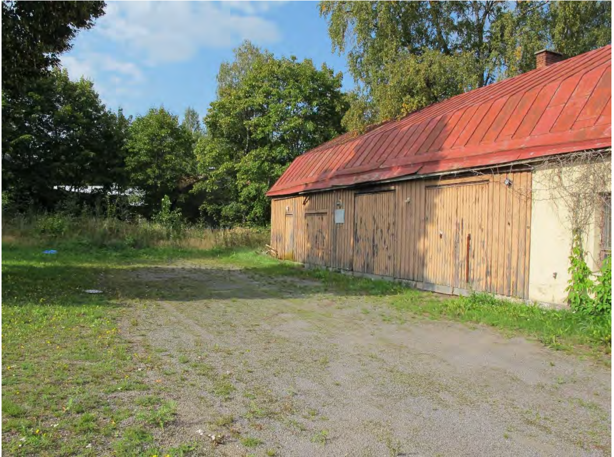
Kuva 3. Umpeenkasvava piha-alue näkyy kuvassa taka-alalla, peltikattoisen rakennuksen länsipuolella.
