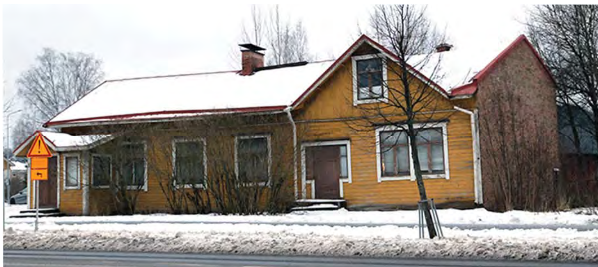
Rakennuksen katujulkisivu. Erityispiirteinä on sen tiilipintainen itäpääty. Tiilipääty on rakennettu paloturvallisuuden vuoksi.
