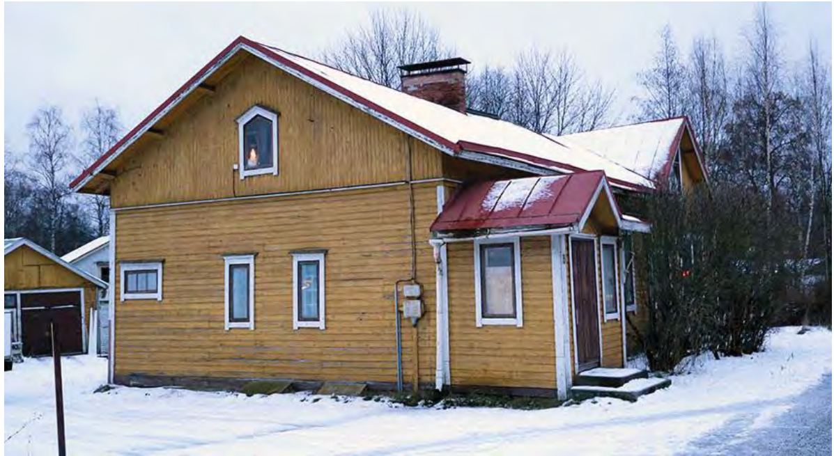
Rakennuksen länsipääty ja katuulkisivua.
