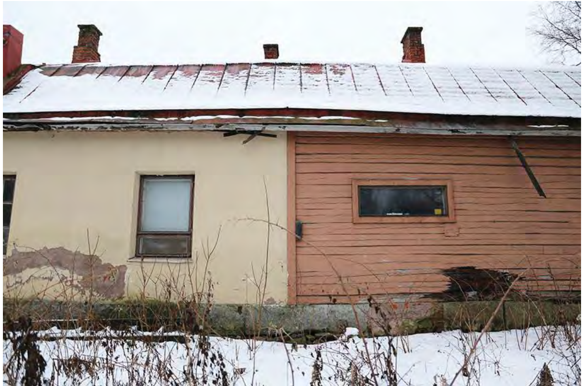
Rapatun pinnan ja hirsipinnan yhtymäkohta.
