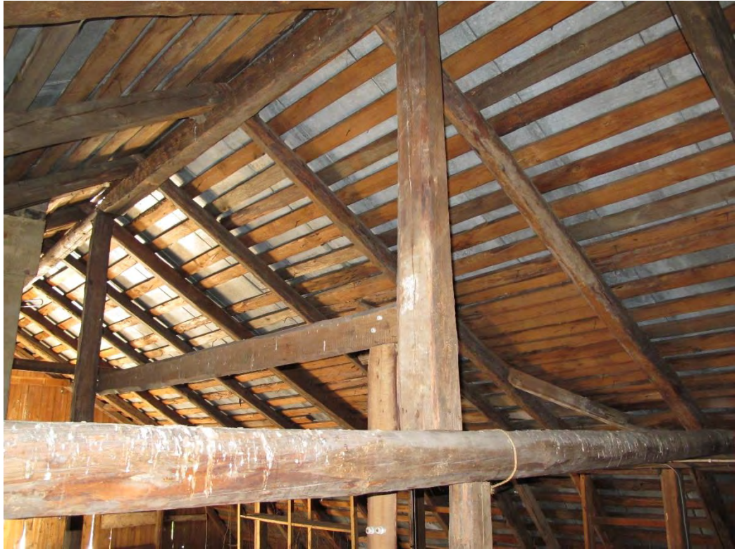
Kuva 3. Kaupungin omistaman rakennuksen ullakkotila.
