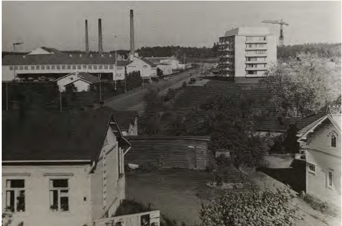
Kuvassa vasemmalla näkyy Tenholankatu 7 ja oikealla Tenholankatu 5. Taustalla Osuusteurastamo Karjaportin tuotantolaitokset ja Rokkalan 1960-luvun alussa rakentuneet tornitalot. Tenholankatu 7:ssä toimi Mikkelin Työväen Osuuskauppa (vuoden 1941 jälkeen Savonseutu) (Suur-Savon museo)
