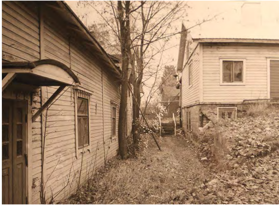
Vasemalla näkyy purettu asuinrakennus ja oikealla paja. Asuinrakennuksessa oli yksi asunto, johon kuului keittiö, olohuone ja kammari. Rakennus jouduttiin purkamaan 1980-luvulla pihan läpi rakennetun viemärin aiheuttamien rakennevaurioiden vuoksi. (Salmisen arkisto)
