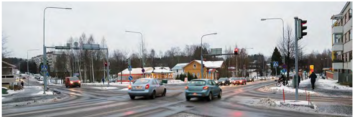
Näkymä Porrassalmenkadun ja Tenholankadun kulmauksesta.
