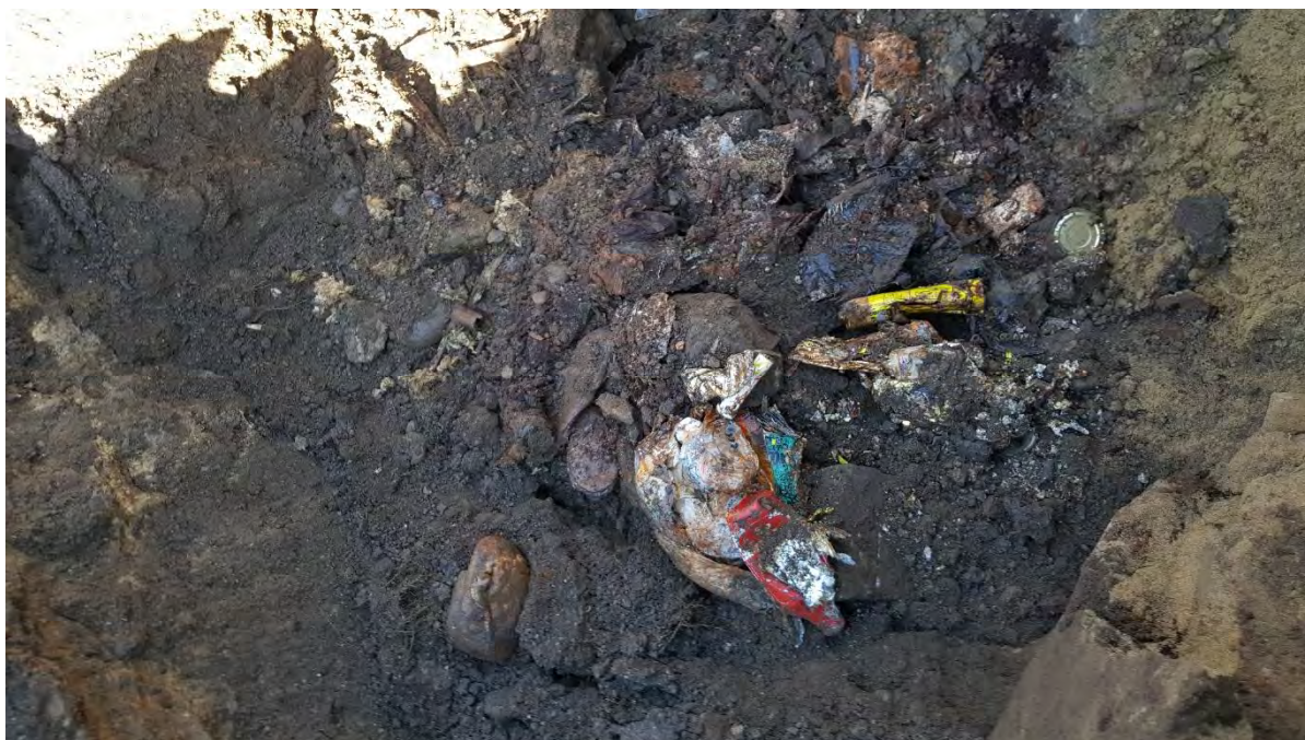
Kuva 2. Koekuopan LT6 jätetäyttöä.
