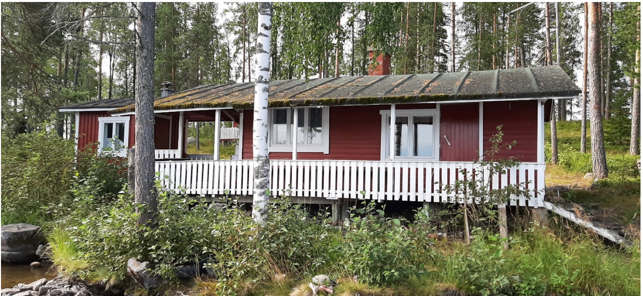
Kuva 2. Purettava lomarakennus Kilpuinsaassa.
