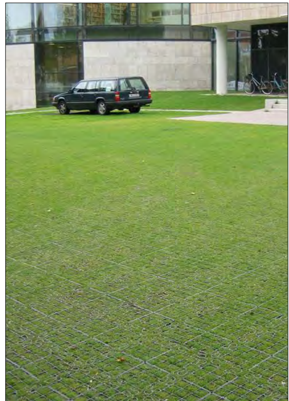
Kuva 9. Muovisella vahvikekennolla tuettuja pysäköintialueita. Kennoa voidaan käyttää vahvistamaan sorapintaa (vasen kuva) tai kenno voidaan vähemmän liikennöidyllä alueella nurmettaa (oikea kuva)
