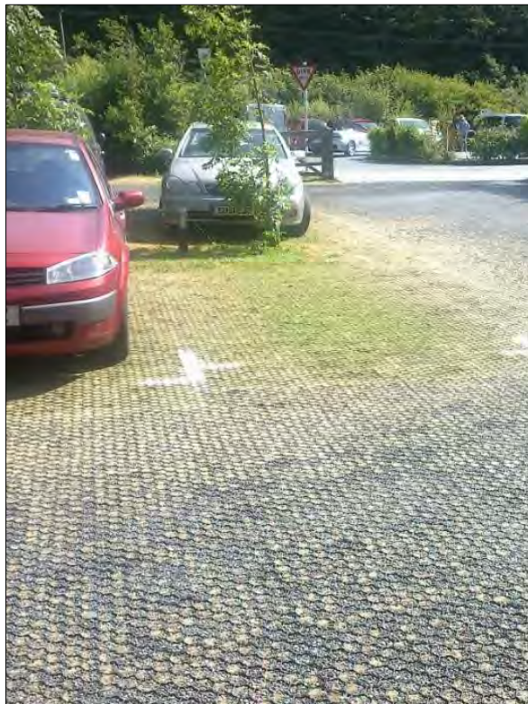
Kuva 9. Muovisella vahvikekennolla tuettuja pysäköintialueita. Kennoa voidaan käyttää vahvistamaan sorapintaa (vasen kuva) tai kenno voidaan vähemmän liikennöidyllä alueella nurmettaa (oikea kuva)
