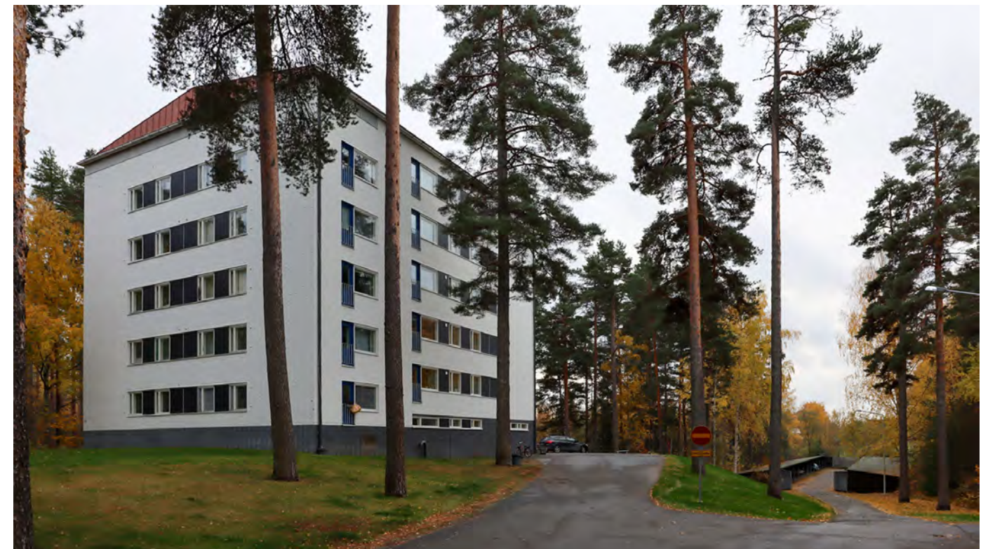
Kuva. Kerrostalo ja autotallit oikealla.
