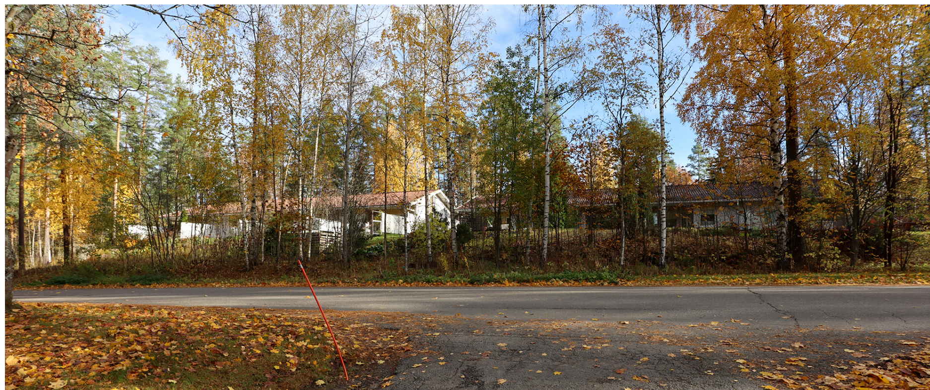
Kuva. 1980-luvulla rakennettuja rivitaloja Moisientien varressa.
