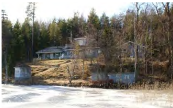
Vasemmallä Annilanranta. (Moisio-Kyyhkylän osayleiskaavan rakennusinventointi 2014)
