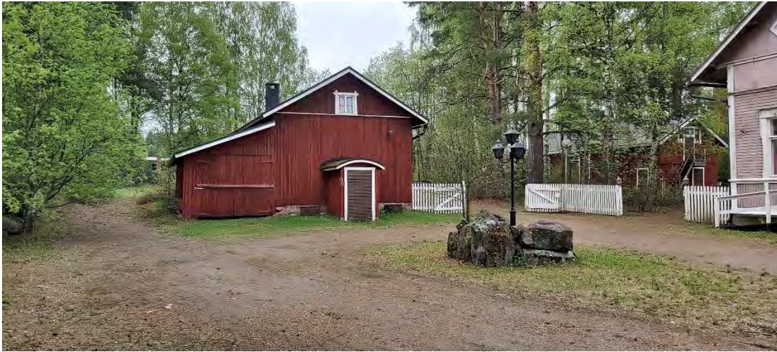
Kuva 18 Kiinteistöllä olevat talousrakennukset ovat julkisivuväritään punamullattuja. Etualalla pohjoisen talousrakennuksen julkisivu länteen.
