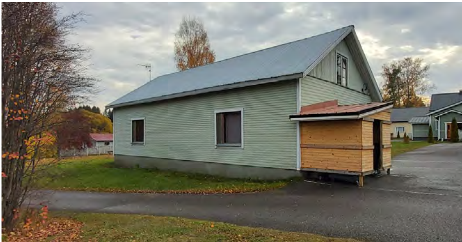
Kuva 58 Talousrakennuksen julkisivua pohjoiseen ja länteen.
