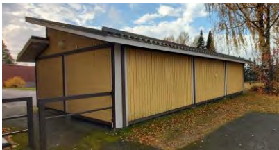
Kuva 5 Kiinteitöllä ijitsevaa talousrakennusta (1961) pohjoiseen ja itään.
