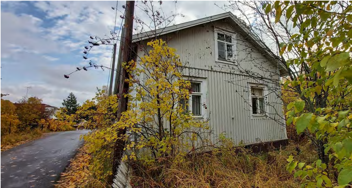
Kuva 101 Rakennuksen julkisivu länteen. Rakennus rajaa Suojatien kapeaa katutilaa.
