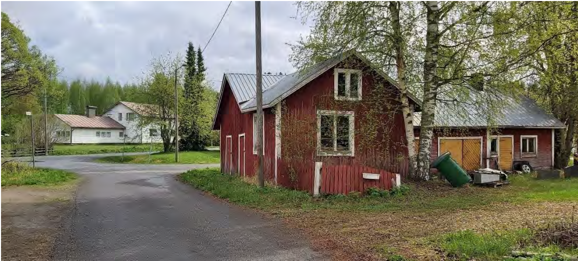
Kuva 70 Itään päin kuvattuna Oikotien kujanteen Suojatien puoleinen pää, jonka maamerkinä on katutiloja rajaava rakennus. Kujanteen päätenäkymässä sijaitsee Koulutien varrella sijaitseva rakennus.
