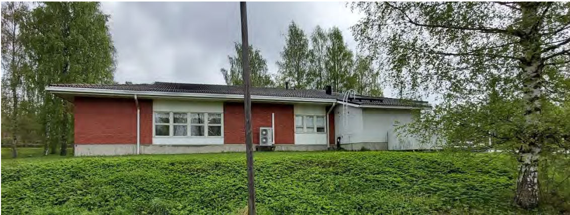
Kuva 30 Kirjaston julkisivu länteen avaraan lähimpäristöön.
