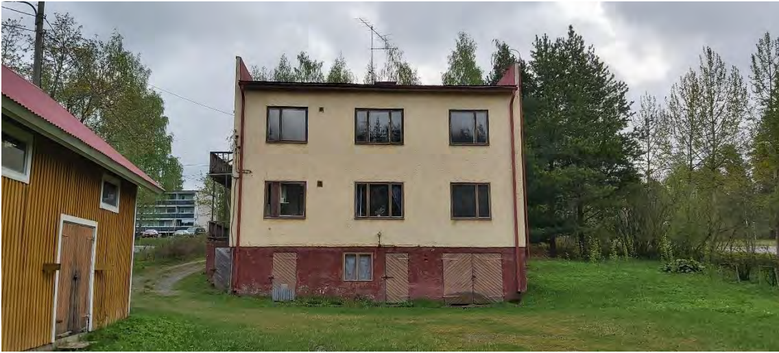
Kuva 20 Keskustie 56:n julkisivu länteen pihan suuntaan.
