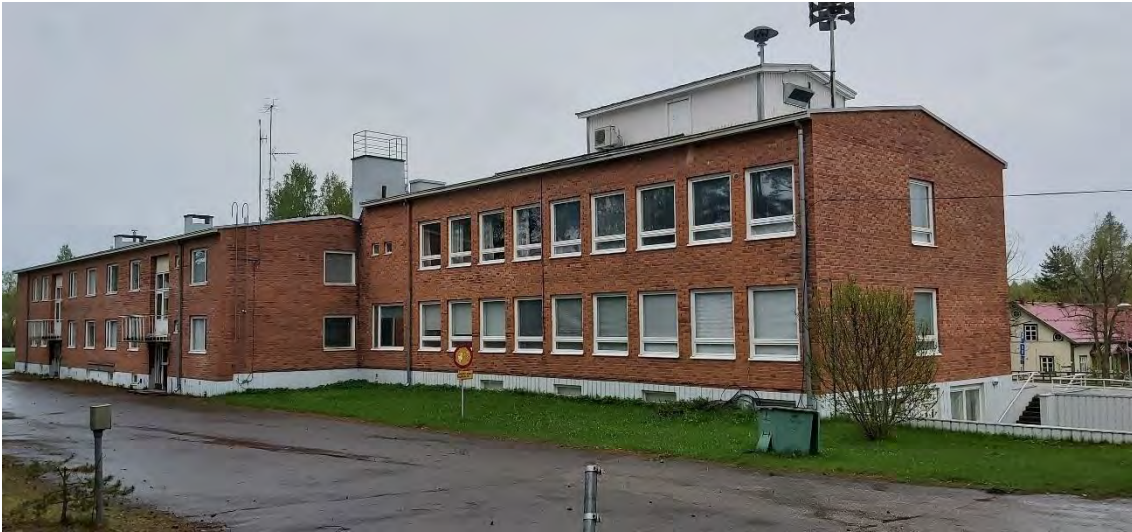
Kuva 37 Entisen kunnantalon julkisivua itään koulun suuntaan.
