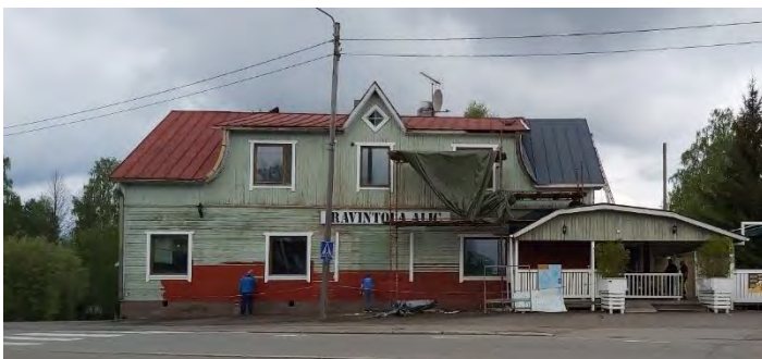
Kuva 59 Rakennuksen kunnostusta, julkisivut ja vesikatto uudistetaan.
