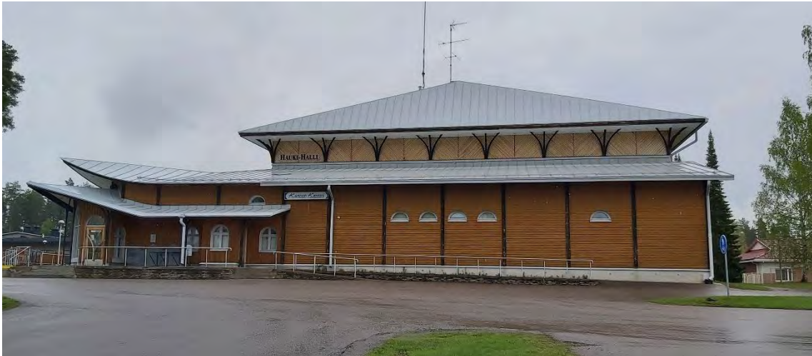
Kuva 41 Hauki-Hallin julkisivu länteen Keskustien suuntaan.
