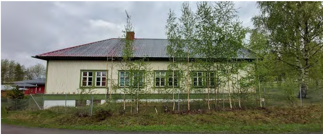
Kuva 33 Entisen kansakoulun ja nuorisotalon julkisivu etelään.
