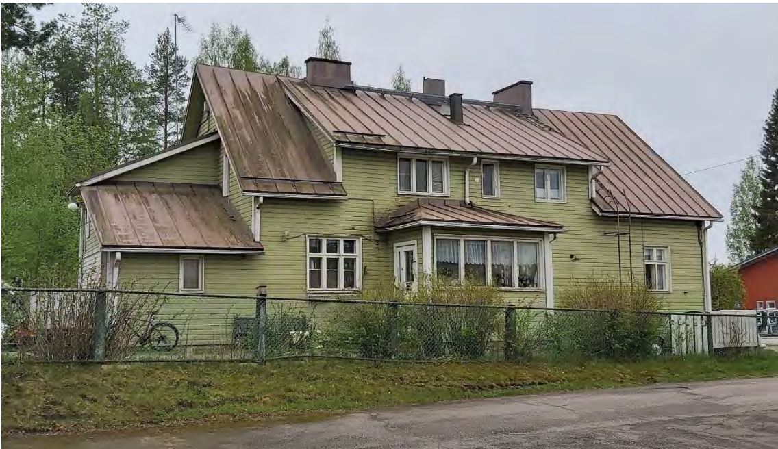
Kuva 82 Rakennuksen pohjoinen julkisivu, jossa sijaitsee rakennuksen pääsisäänkäynti.
