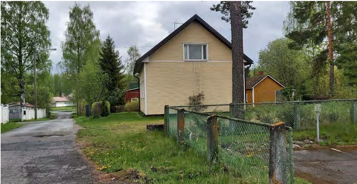
Kuva 69 Oikotien eteläpuoli ei ole yhtä vahvasti rajattu kuin pohjoispuoli. Eteläpuolella kiinteistöjen talousrakennukset ovat tärkeä, rytmittävä osa kujamiljöötä. Osa rakenteellisista aidoista on metalliverkkoa. Kuvassa kujannetta itään päin.
