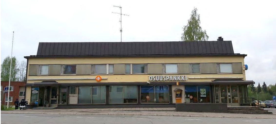
Kuva 3 Osuuskassan liiketalon pääjulkisivu itään Keskustien suuntaan.
