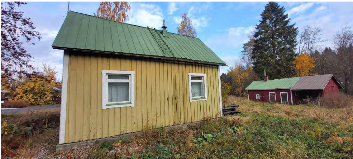
Kuva 105 Päärakennuksen julkisivu etelään ja talusrakennuksen julkisivu länteen Suojatien suuntaan.
