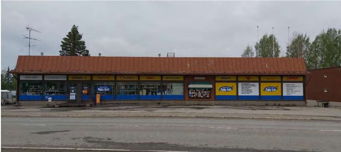
Kuva 61 Wanhan Osulan pääjulkisivu itään Keskustien suuntaan.
