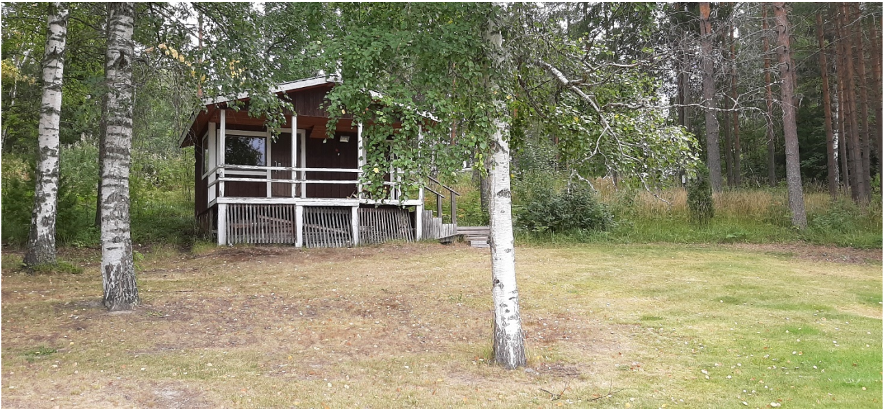
Kaislarannan tilan toinen purettava aitta tilan pohjoisosassa.
