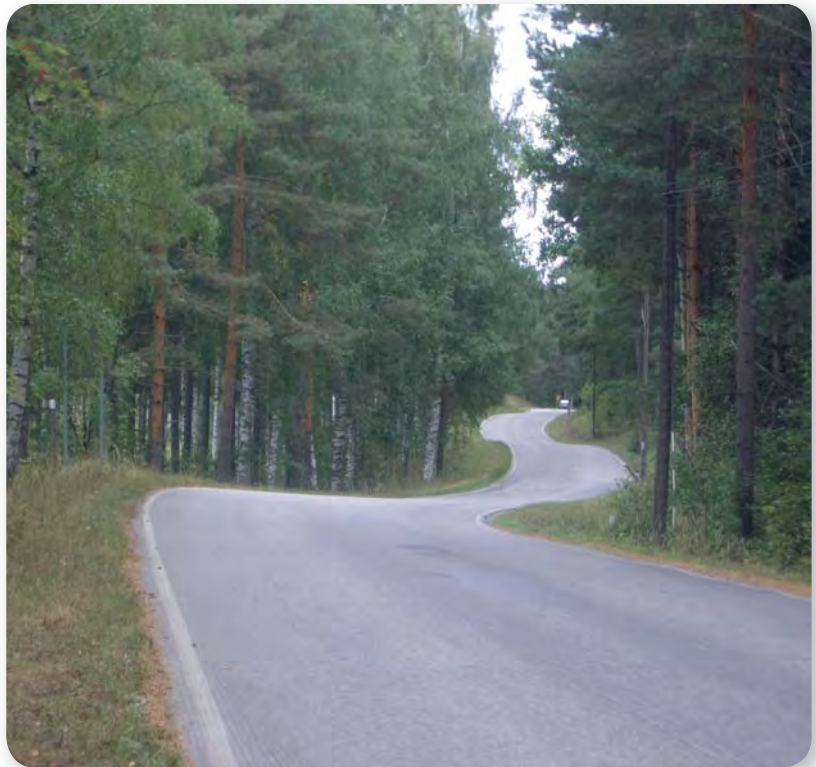
Kuva 46 ja 47. Tien geometria on pienipiirteinen ja näkemät monin paikoin huonoja. Ajonopeus on tällöin pidettävä riittävän alhaisena.
