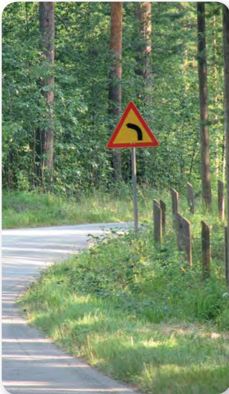
Kuva 46 ja 47. Tien geometria on pienipiirteinen ja näkemät monin paikoin huonoja. Ajonopeus on tällöin pidettävä riittävän alhaisena.
