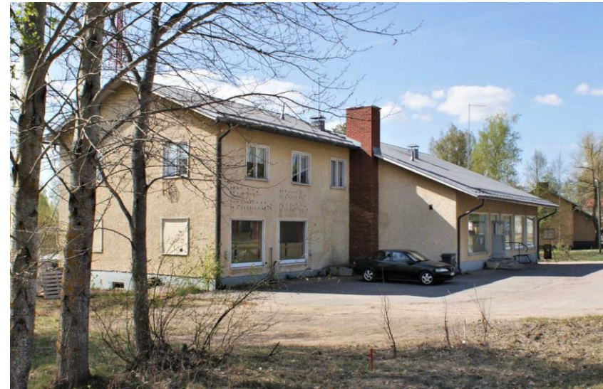
Kuva: Osuuskauppatalo on lautarunkoinen ja rapattu. Asuntoapuolelta on alakerroksen ikkunoita suurennettu ja toimistohuoneen sisäänkäynti poistettu.
