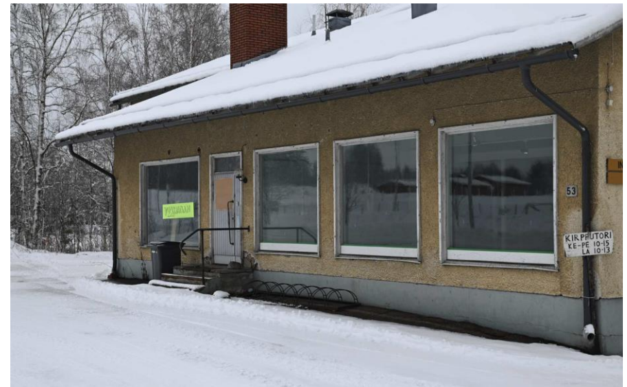
Kuva: Julkisivu tielle eli itään. Lasiaukollinen paneeloitu puuovi pitkällä vetimellä ja jaottomat smyggilautojen rajaamat näyteikkunat alkuperäisessä koossaan.
