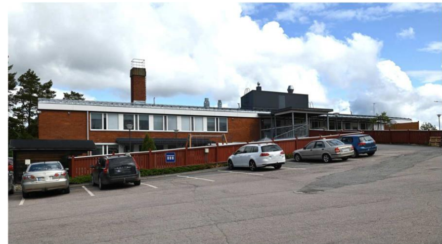
Kuva: Emäntäkoulun päärakennus on rungoltaan suorakaiteen muotoinen ja loivalla harjakatolla varustettu.
