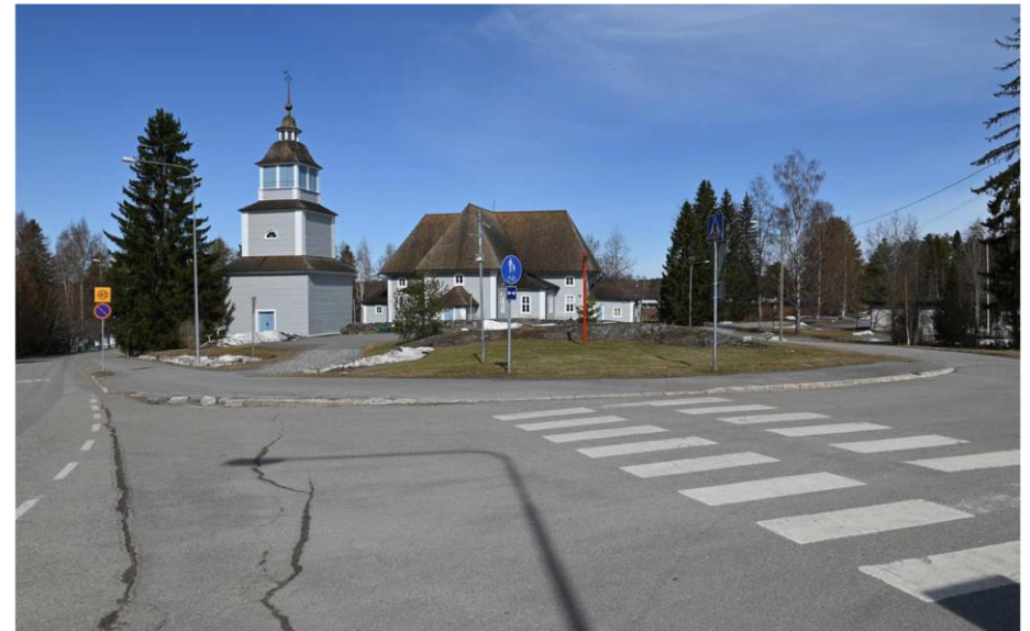
Kuva: Kirkko ja kellotapuli keväällä 2023. Risteys ja kadut ovat päällystettyjä.
