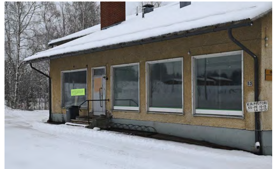
Kuva: Julkisivu tielle eli itään. Lasiaukollinen paneeloitu puuovi pitkällä vetimellä ja jaottomat smyygilautojen rajaamat näyteikkunat alkuperäisessä koossaan.
