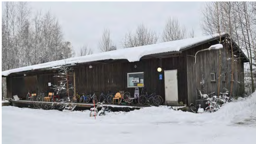
Kuva: Varastorakennus, jossa on toiminut mm. pyöräkorjaamo.
