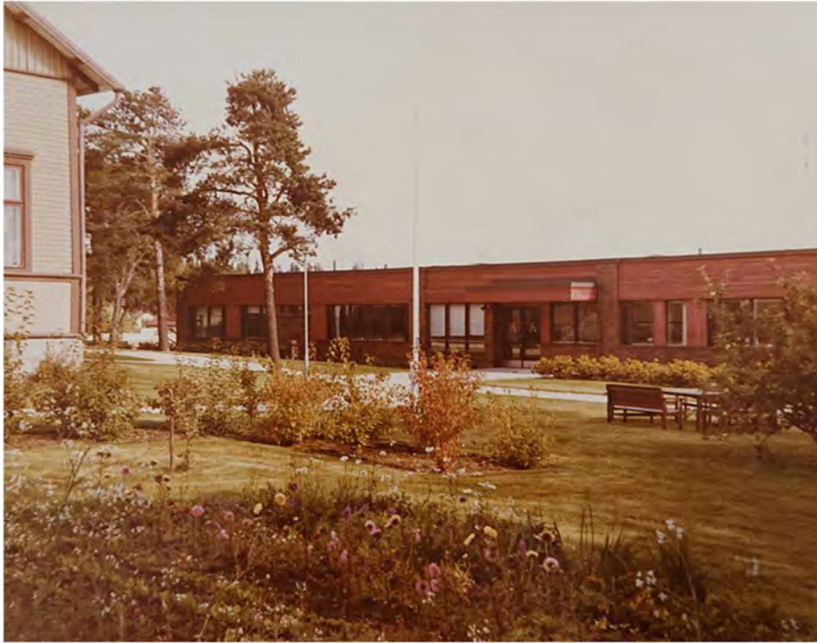
Kuva: Talouskoulun lisärakennus oli valmistuessaan tasakattoinen. Yläpihalle näkyy vain toinen kerros, Rauhankadun puoli on kaksikerroksinen. Julkisivuissa käytetty vaakalaudoitus on kuultomaalattu kirsikanpunaiseksi. / Kotitalousoppilaitoksen arkisto.
