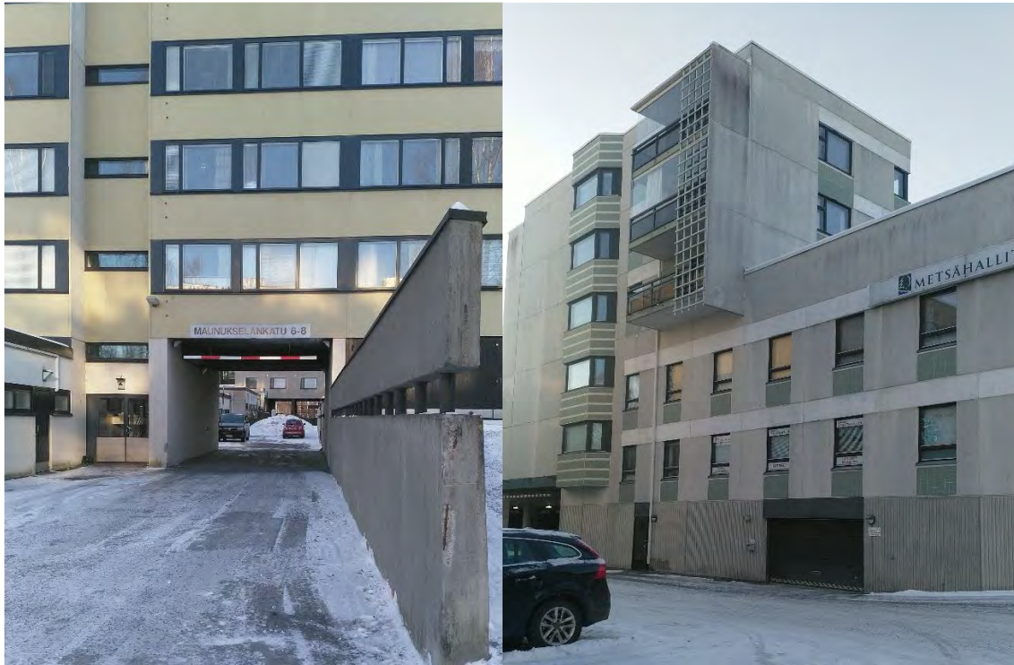
Kuvat 4-5. Valokuvissa näkyy korttelin arkkitehtuuria. Vasemmalla korttelin läpi maantasossa kulkeva näkymäakseli. Oikealla korttelin tuorein asuin- ja liikerakennus 1980-luvulta.
