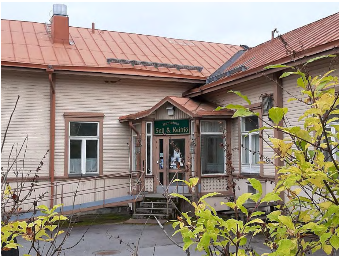
Kuva 1. Kuvassa näkyy Lähemäen entisen kansakoulurakennuksen pääsisäänkäynti.
