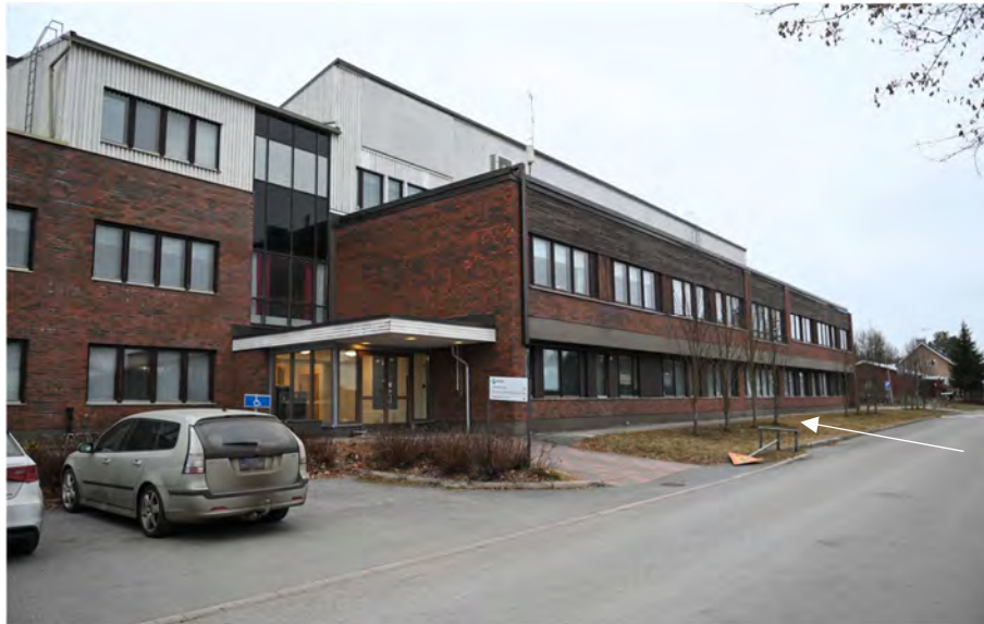
Kuva: Rauhankadun puoleinen julkisivu. Etualalla 1990 valmistunut osa. Lisärakentamisen yhteydessä vanhan puolen katujulkisivusta poistettiin pääsisäänkäynti (paikka osoitettu nuolella). Nykyistä pääoven katosta on suurennettu 2004.
