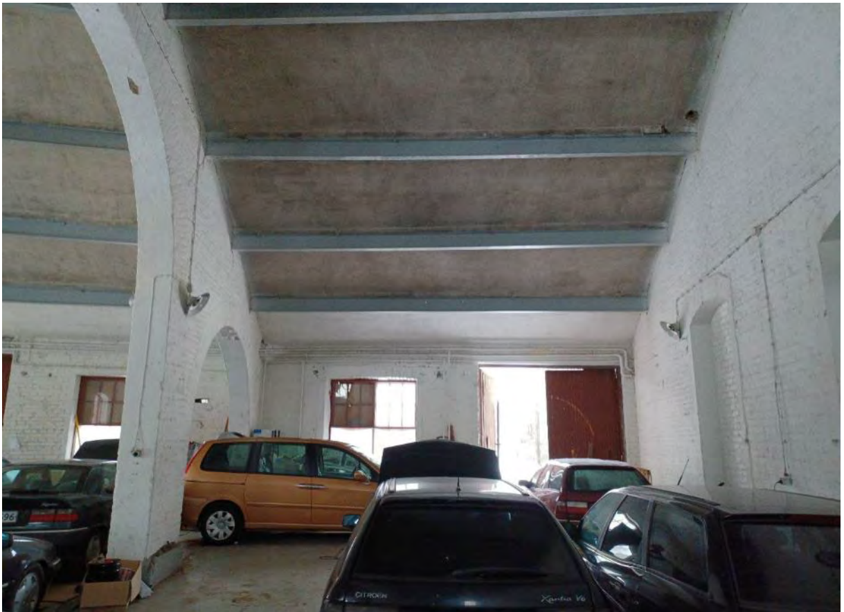
Kuva 104. Tila kuvattuna kohti toista sisäänkäyntiä (ovi 12).
