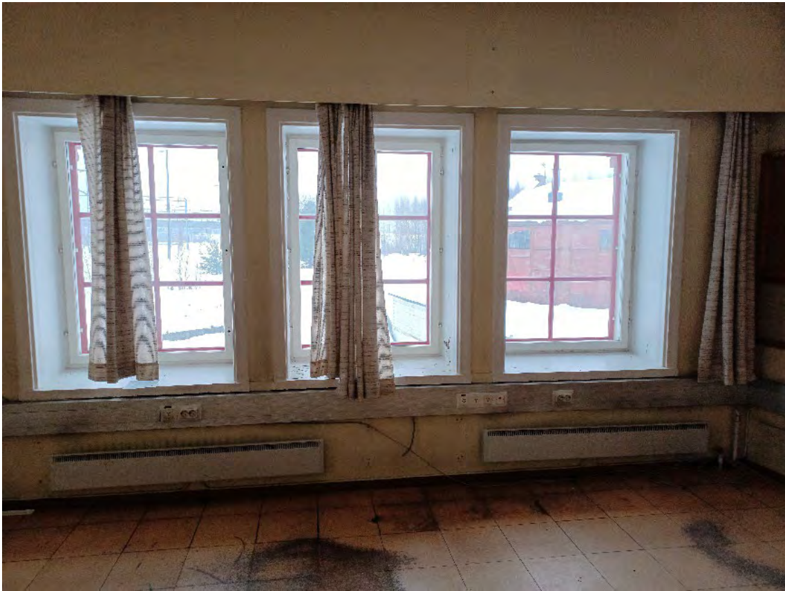
Kuva 71. Isompi toimistohuone, jonka ikkunat ovat sisäpihalle päin.
