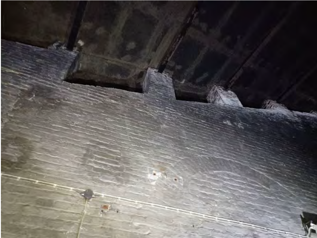
Kuva 91. Tila 7. Kattokulmaa on muutettu ulkokaaren eli laajennusosan puolella. Sisäkatto on levytetty.
