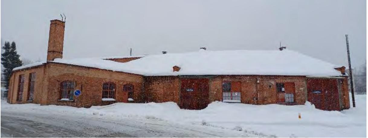
Kuva 33. Rakennuksen idänpuoleinen julkisivu.
