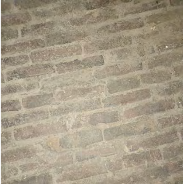
Kuva 75. Lattia on ladottu punatiillistä.
