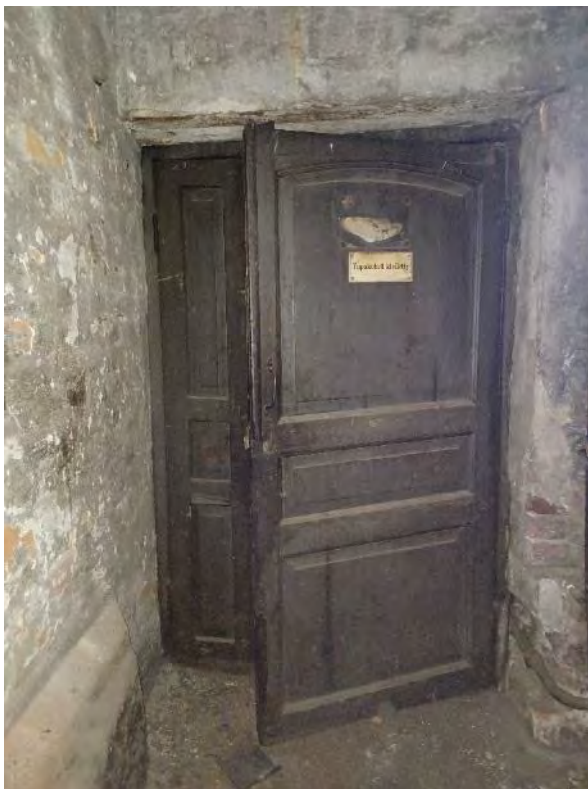
Kuva 84. Entisen vesitornin sisäänkäynti tila nro 9 puolelta.
