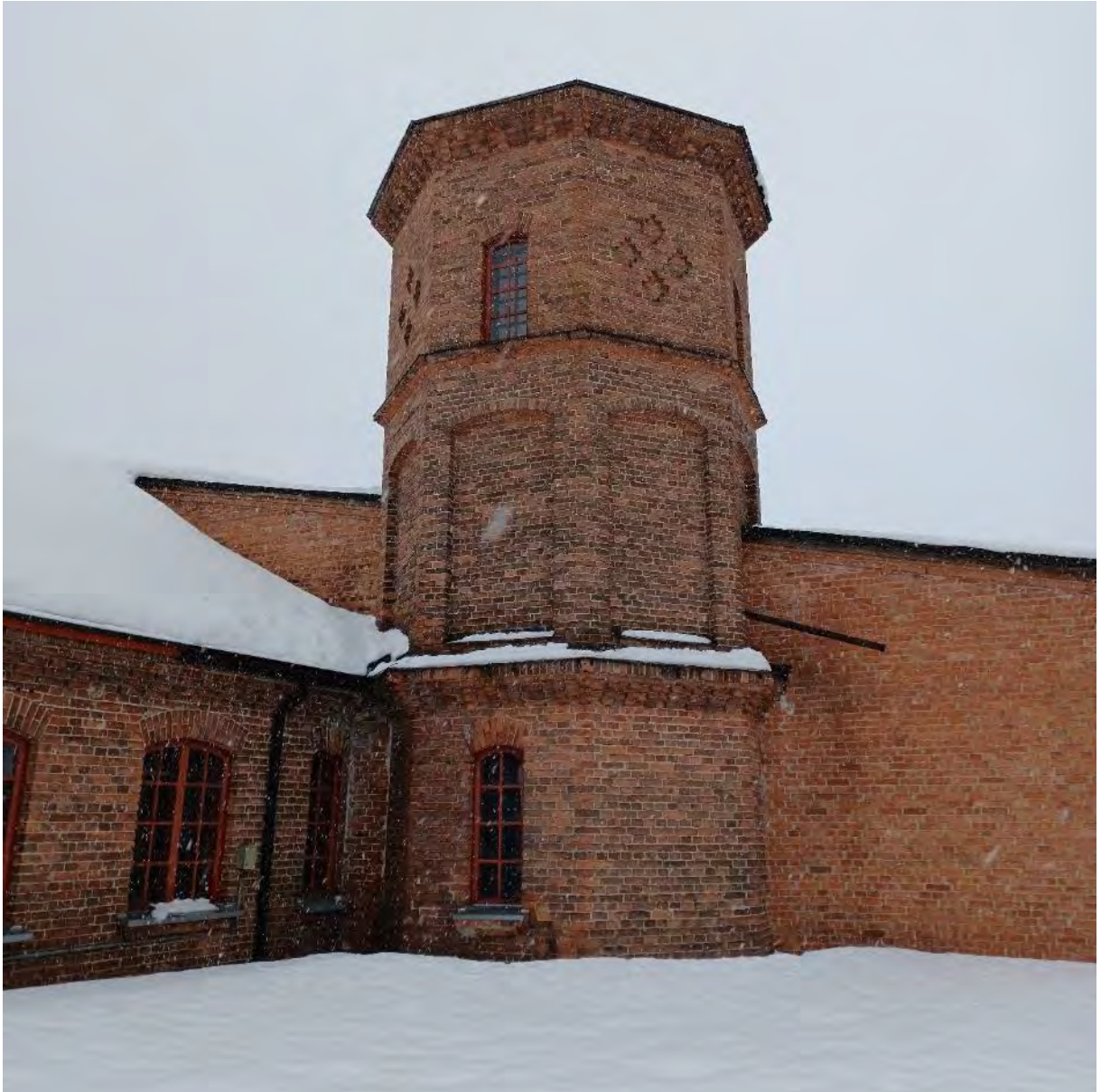
Kuva 41. Vesitorni vuodelta 1889 kuuluu rakennukseen vanhimpiin osiin (tila nro 10). 1940-luvulla tehty laajennusosa erottuu julkisivussa vaaleampana ja niukemmin koristeltuna.
