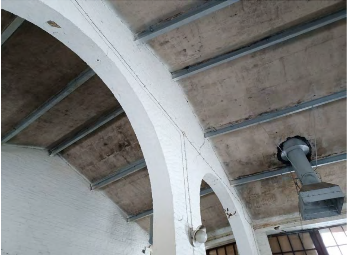
Kuva 108. Sisäkatto on pinnoitettu tunnistamattomalla tasoitteella. I-palkit on maalattu harmaiksi.
