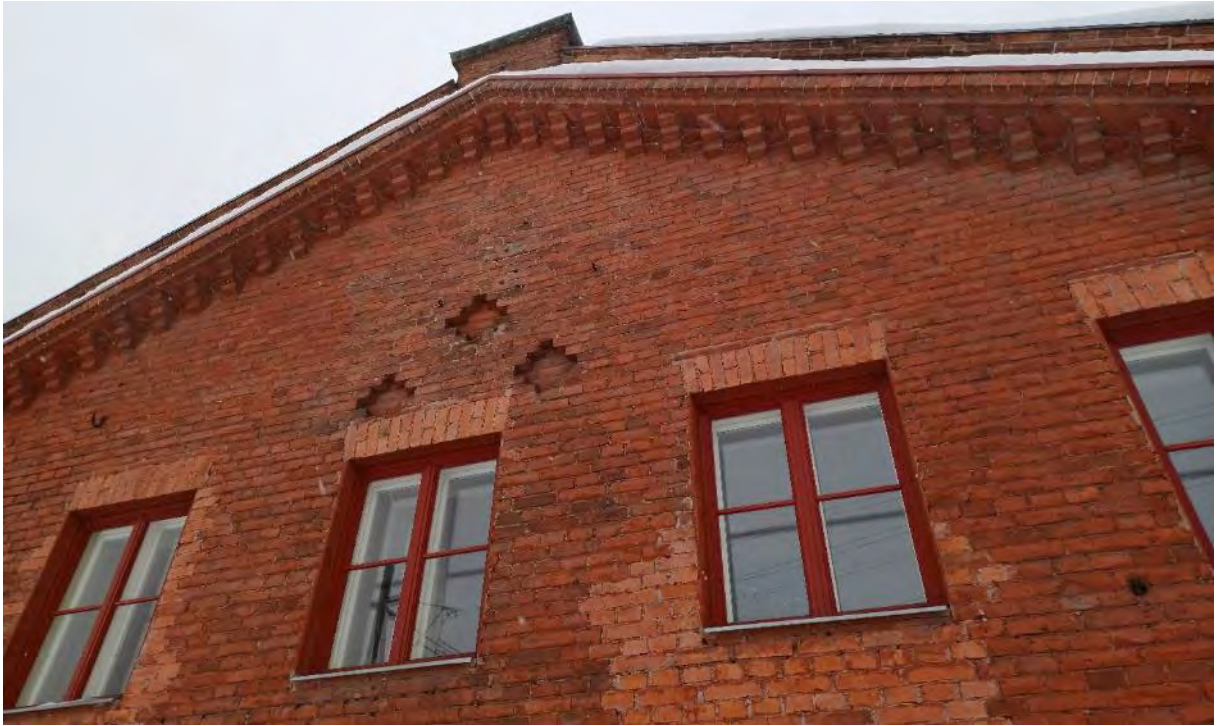
Kuva 56. Toimistopäädyn ikkunoita länteen päin.
