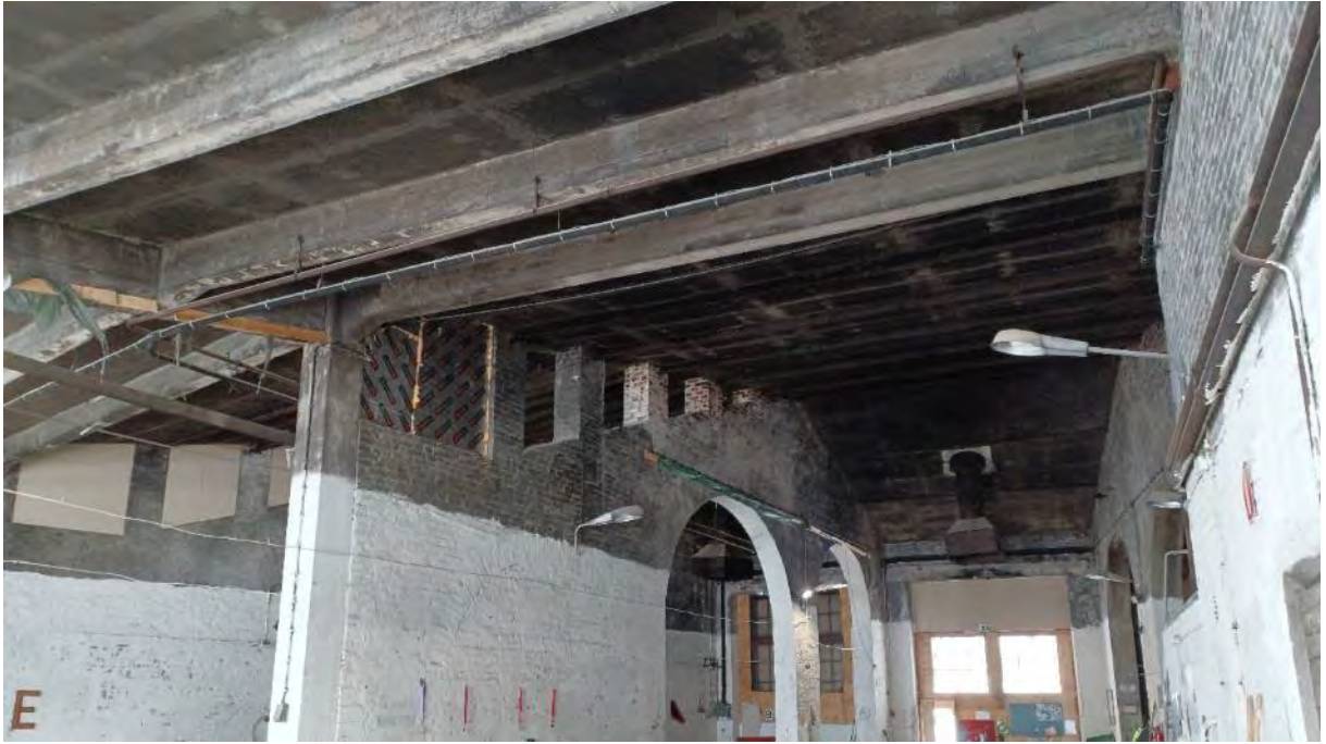
Kuva 100. Alkuperäinen kattomuoto näkyy väliseinärakenteissa aukkoina, joita on tukittu erilaisin materiaalein.
