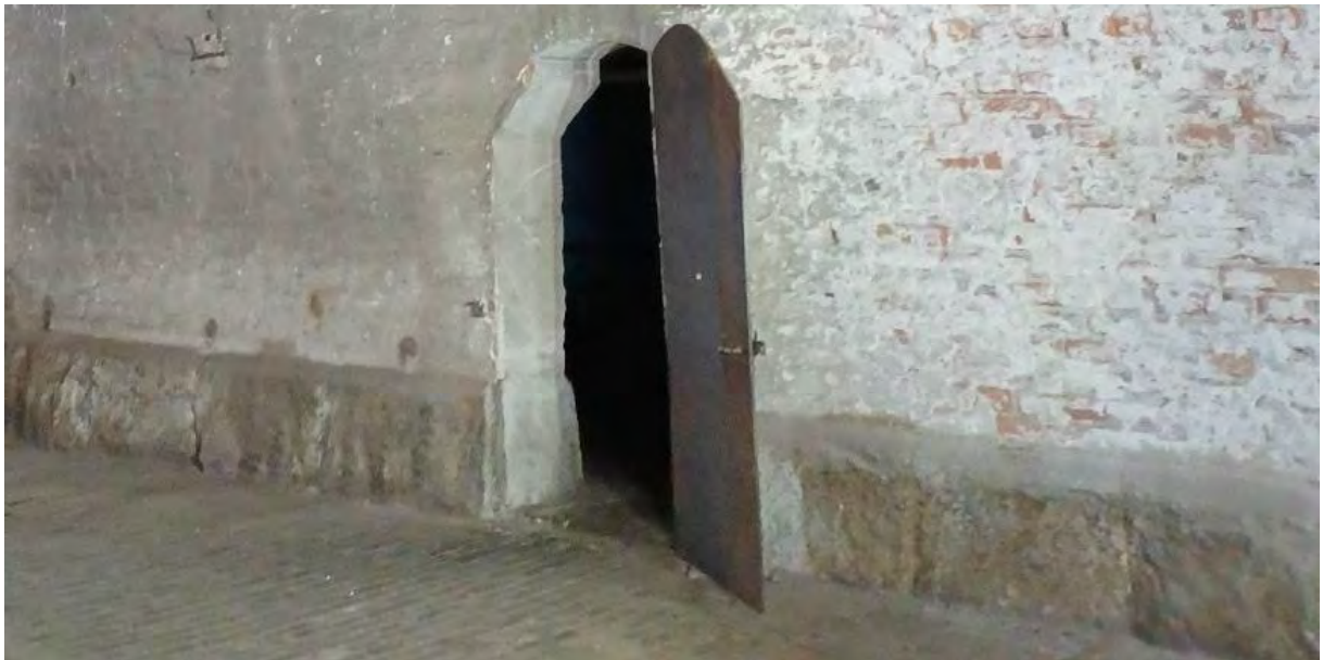
Kuva 32. Kuvassa näkyvä nykyinen väliseinä on alun perin ollut ulkoseinä. Sokkeli on luonnonkiveä, samoin perustukset. Lattia on ladottu tiilistä.
