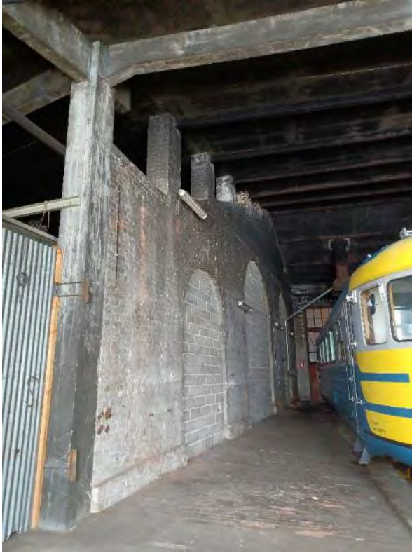
Kuva 93. Tila 6. Väliseinän kolme suurta holvikaarta on muurattu umpeen kevytbetoniharkoin, mutta yhteen on jätetty kulkuaukko.
