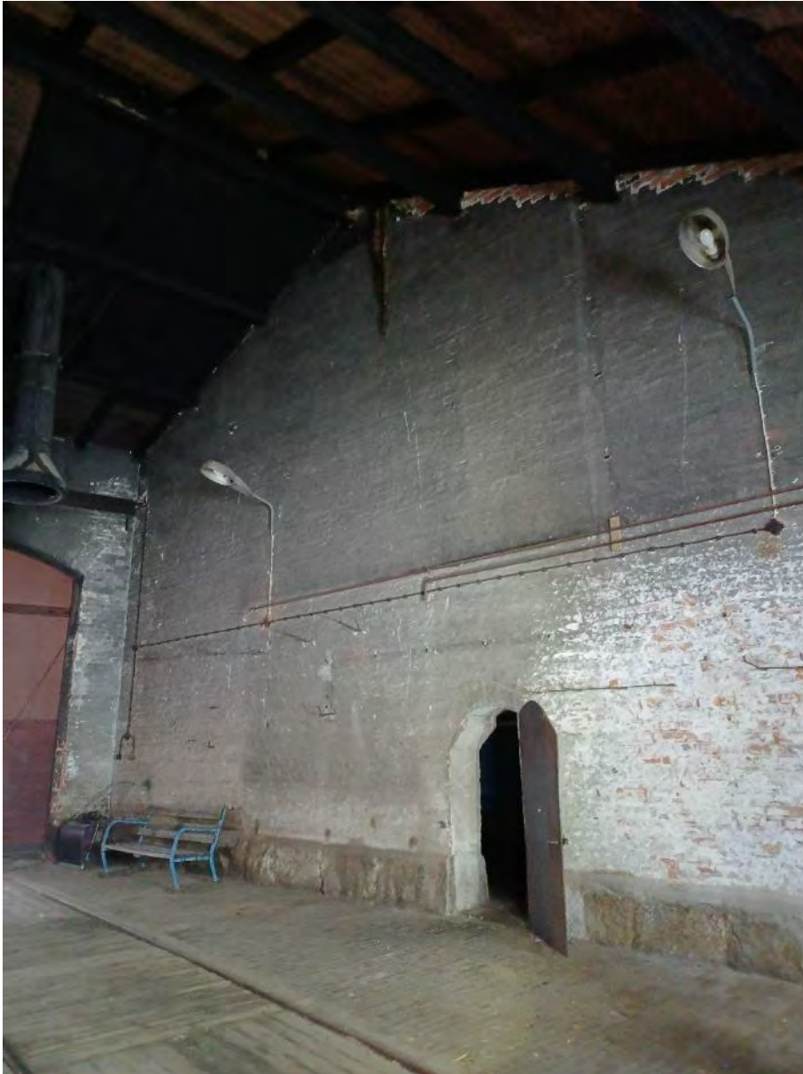
Kuva 77. Veturitalli oli aluksi kaksipilttuinen, ja tämä seinä on ollut ensimmäisen rakennusvaiheen (1889) ulkoseinä.
