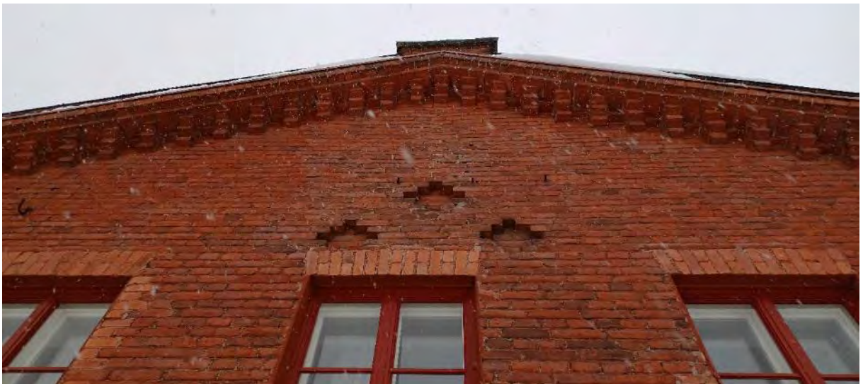
Kuva 39. Tiilikoristeluita länsipäädyssä. Tämä vanhin osa rakennuksesta – kaksi ensimmäistä pilttuuta sekä vesitorni – on kaikkein runsaimmin koristeltu.
