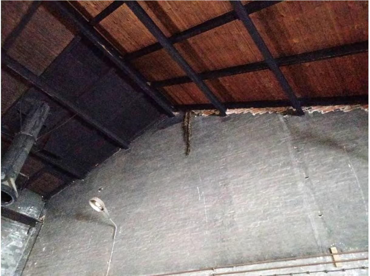
Kuva 81. Kattorakenteita kannattelevat teräksiset I-palkit. Kattotuolit ja aluskate ovat puuta. Valaisin on myöhempää perua.
