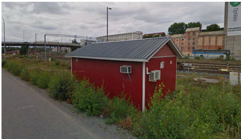
Kuva 19. Rautatiehen liittyvä sähkömuuntamo (Google 2011)
