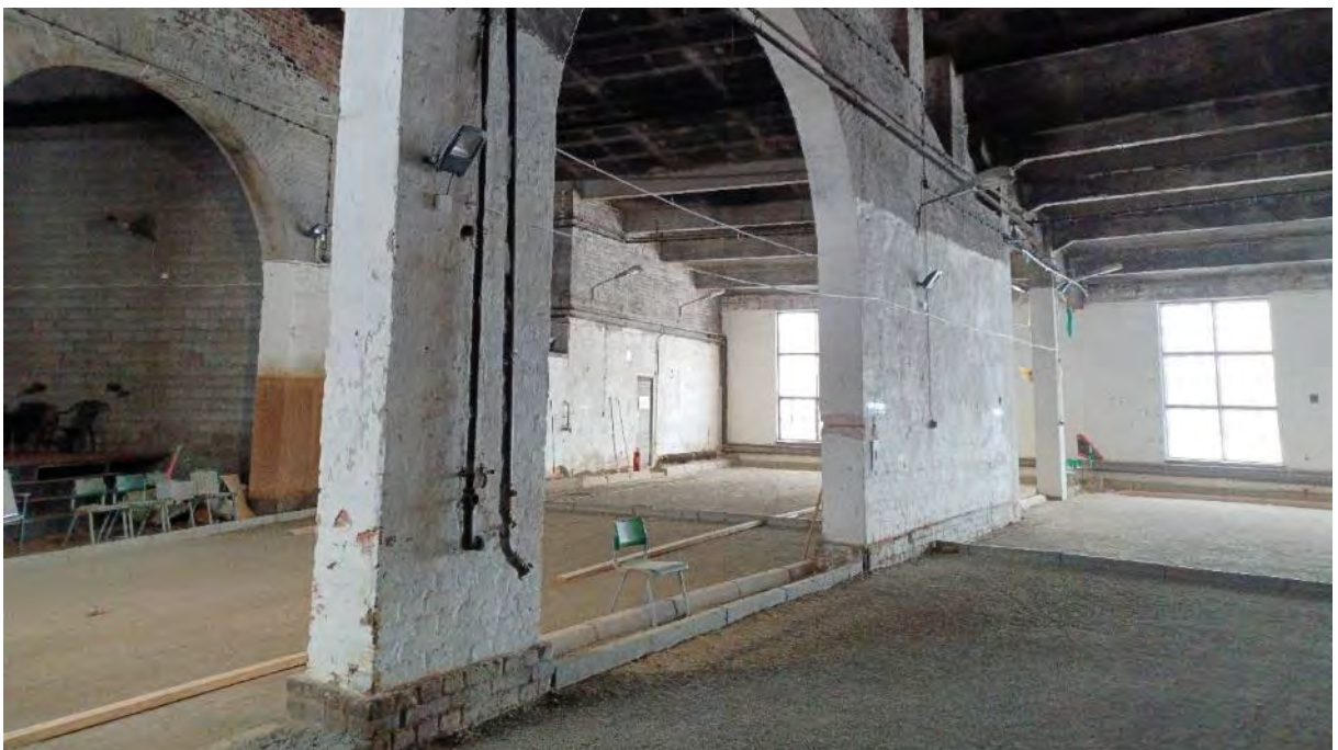
Kuva 97. Pilttuiden lattiapinnat on päällystetty hiekalla.
