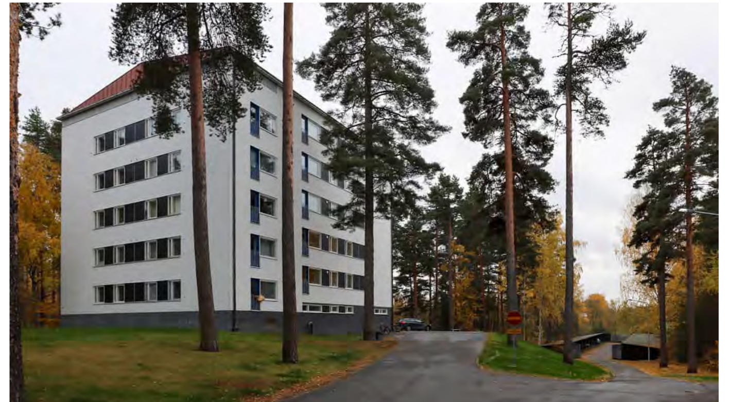
Kuva. Kerrostalo ja autotallit oikealla.
